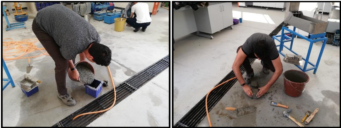
Şekil 3.3. Hazırlanan beton karışımlarının kalıplara yerleştirilmesi.
