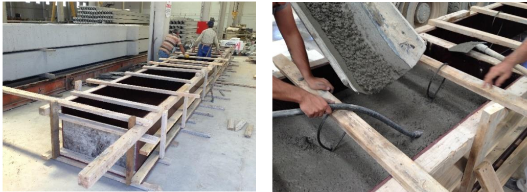
Şekil 4.1. Ankrajların ekileceği temellerin hazırlanması ve beton dökümü.
