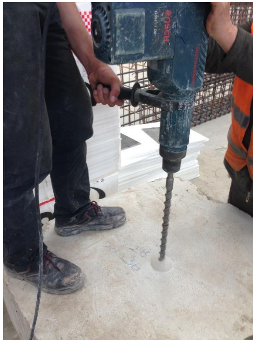
Şekil 4.2. Ankrajların ekileceği deliklerin açılması.
