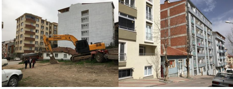
Şekil 50. 141. Bölgedeki İnşa Faaliyetleri ve Yeni Konutlar
