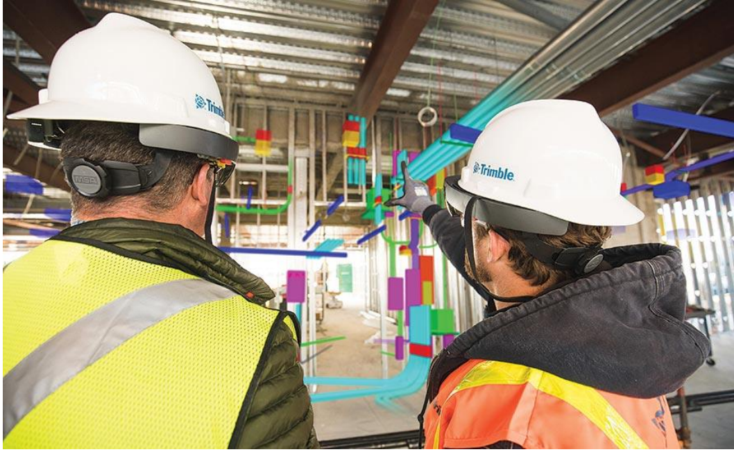
Şekil 3.12. Trimble yazılımı ve karma gerçeklik aracı Microsoft HoloLens ile şantiye uygulaması (Burczyk, 2019 ).
