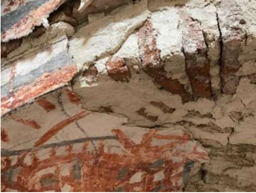
Fotoğraf 5: İsa Sofu Türbesi tuğla örgü sistemi ve sıva detayı.
