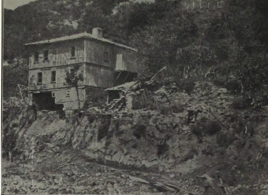
Resim 5: Heyelandan etkilenen Cumalı Mahallesi'nde harap bir ev. (Ahmed Müştak vd.,1340: 33)
