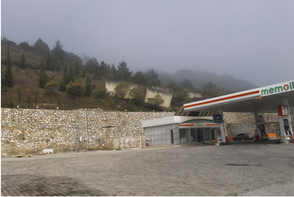
Resim 6: İstanbul-Antalya Yolu; Geyve'ye bağlı Bağlarbaşı Köyü yakınında heyelana maruz kalan istinat duvarları.
