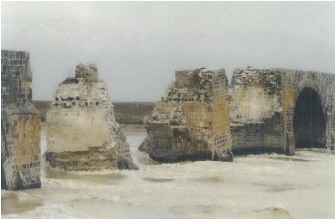
Şekil 2.2. Murat Köprüsü Yıkılan Kemerler Mansap Görünüşü 2 Kaynak: (Öztürk, 2005: 8)
