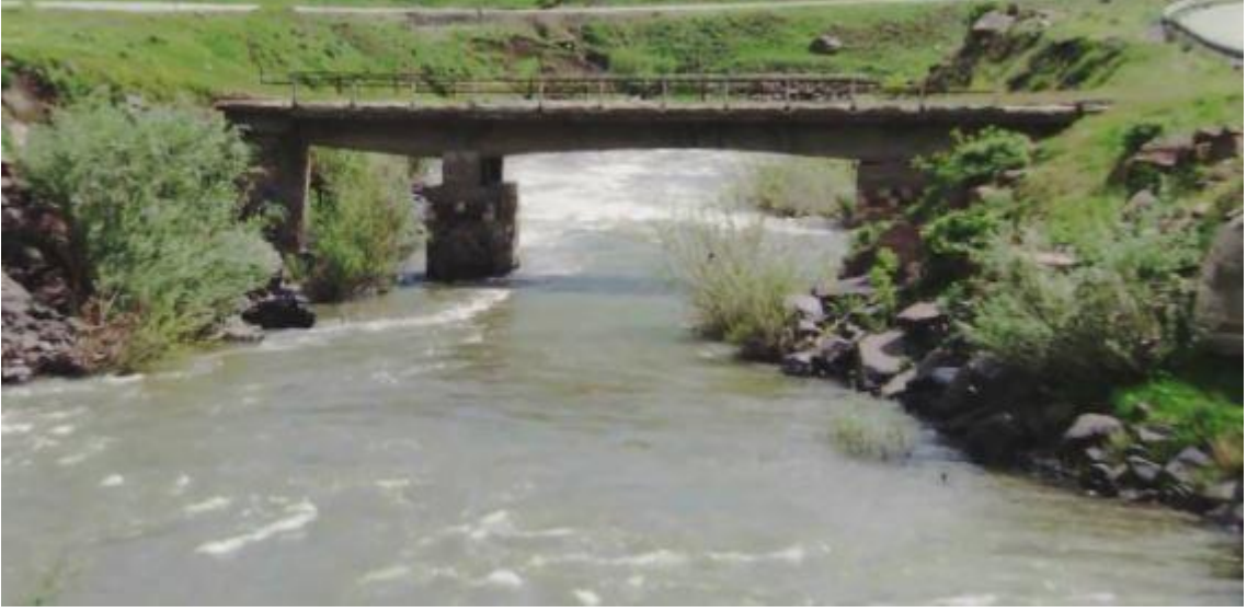
Şekil 1.21. Abdurrahman Paşa Köprüsü Kaynak: (Muş İl Kültür Turizm Müdürlüğü-Köprüler, 2020)
