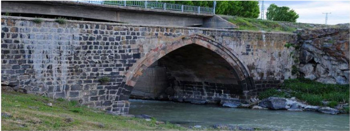
Şekil 1.17 Malazgirt (Hatun) Köprüsü Memba Cephesi Kaynak: (Muş İl Kültür Turizm Müdürlüğü-Köprüler, 2020)
