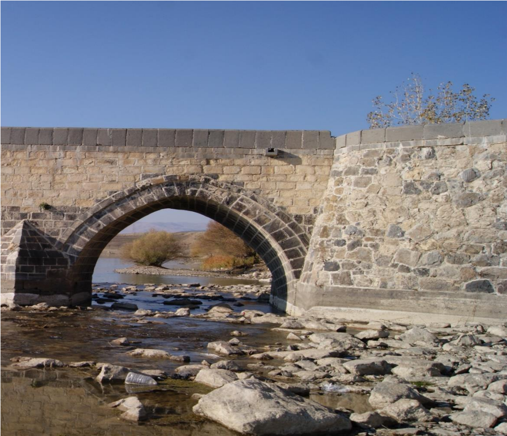
Şekil 2.14. Nehir Kıyısı Birleşim Ayağında Kullanılan Moloz Taşları
