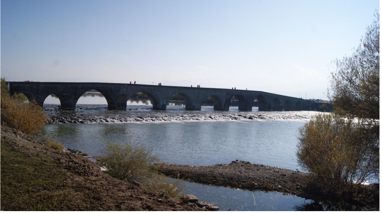
Şekil 2.5. Murat Köprüsü Mansap Görünüşü
