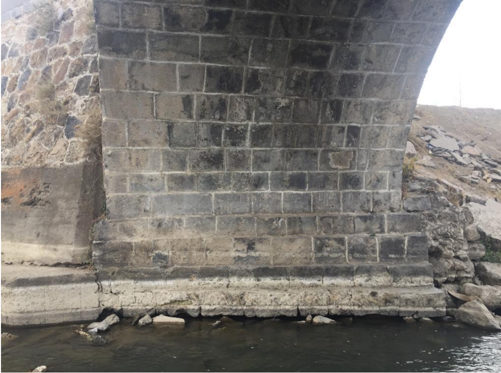
Şekil 2.17. Murat Köprüsü A1 Ayağında Oluşan Temel Boşalmaları ve Kemer İç Yüzeyinde Oluşan Kirlenmeler, Kireçlenmeler.
