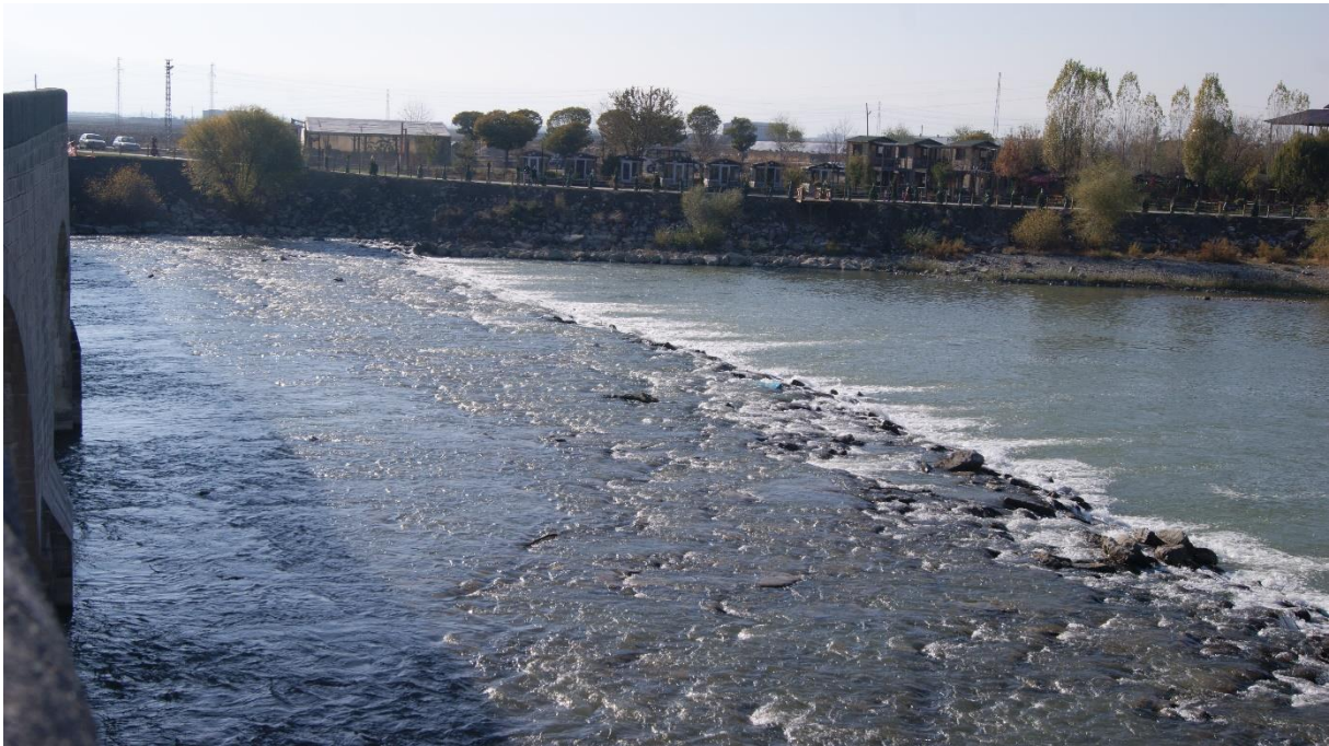
Şekil 2.12. Mansap Bölgesinde Yalan Tahkimat
