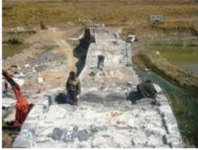
Şekil 2.4. Murat Köprüsü Onarım Çalışmaları Kaynak: (Evrensel, 2004)
