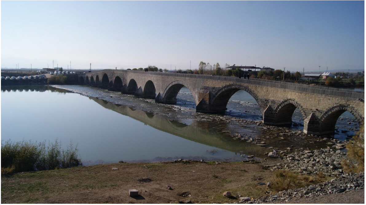
Şekil 2.6. Murat Köprüsü Memba Görünüşü
