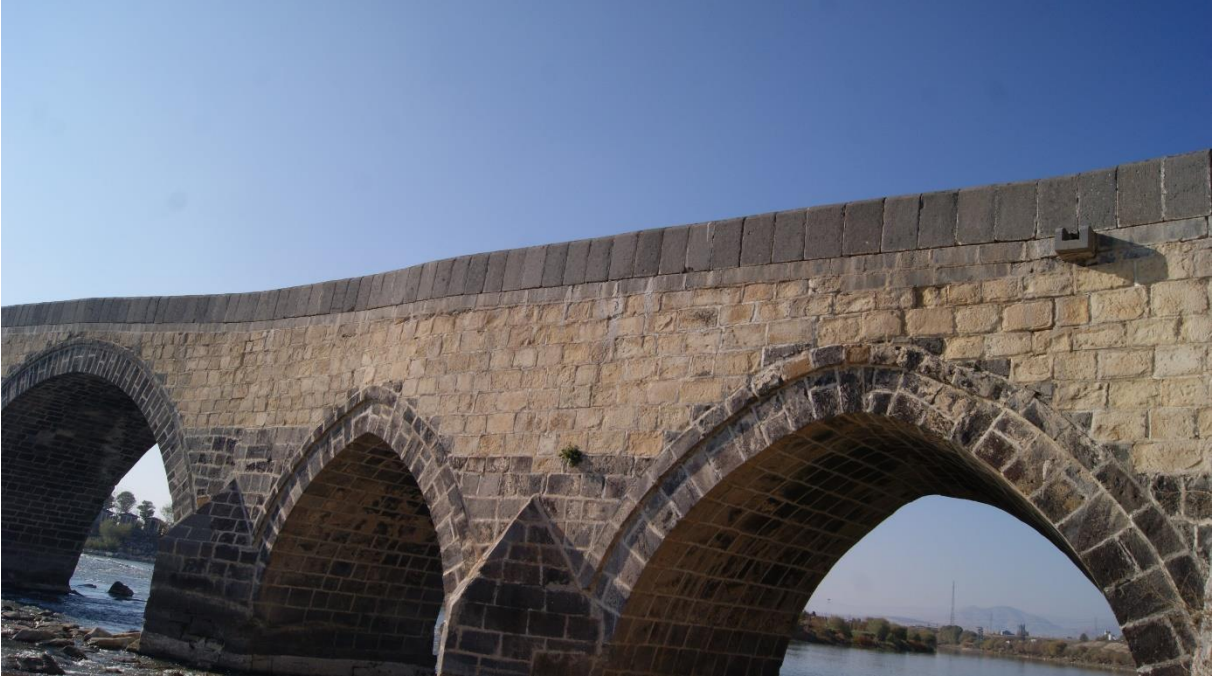
Şekil 2.13. Murat Köprüsü Tempan Duvarında Kullanılan Farklı Taşlar
