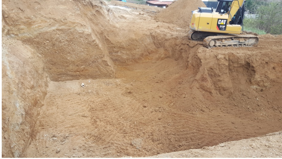
Şekil 5.3. Şev bölgesine ait kazı.
