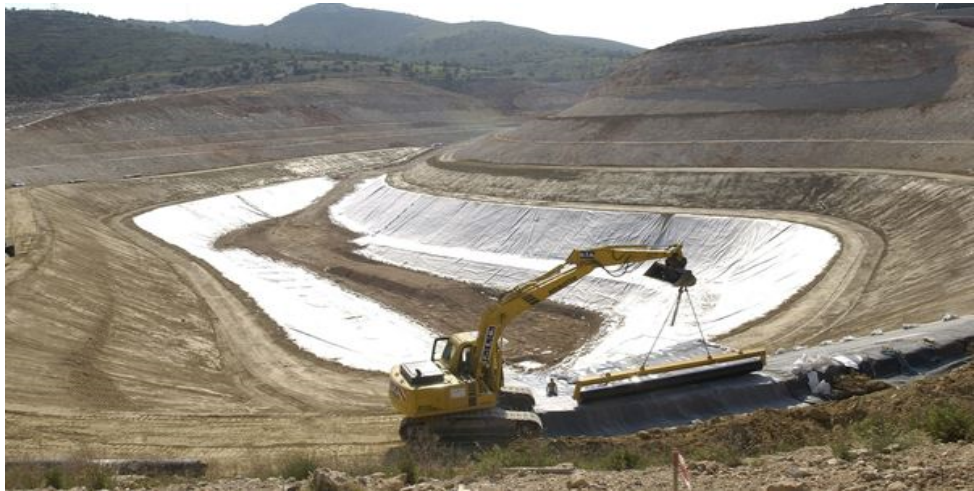
Şekil 3.4. Depolama alanı için yapılan şev (Url-3).
