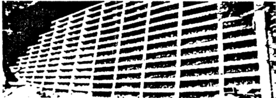
Şekil 3.28. Sandık duvarı görünümü (Bromhead, 1986).
