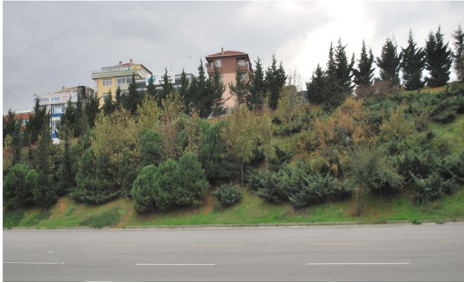
Şekil 3.25. Bir karayolu kenarındaki şeve uygulanan bitkilendirme (Ur1-4).
