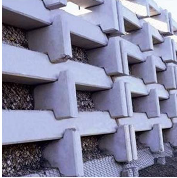
Şekil 3.27. Dolgulu çerçeve duvarı (Tekin, 2011).
