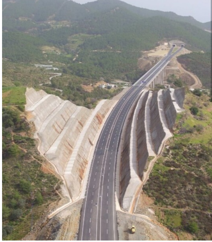
Şekil 3.3. Karayolu için yapılan yarma şevi (Url-2).
