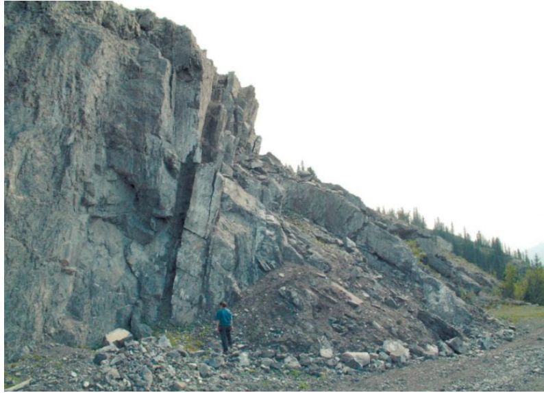
Şekil 3.14. Devrilme, Kanada (Cruden ve Varnes, 1996).
