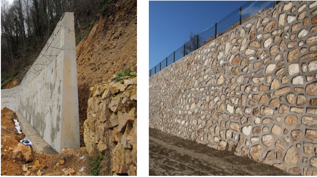
Şekil 3.26. Konsol ve ağırlık istinat duvarları (Url-5-6).
