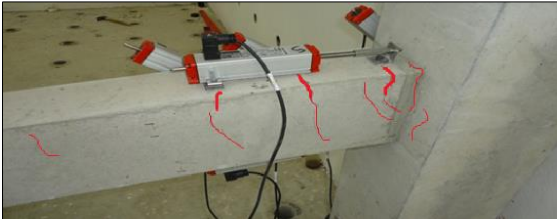
Şekil 4.135. S15 deney elemanında meydana gelen çatlak gelişimi
