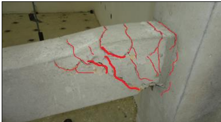
Şekil 4.90. S10 deney elemanında meydana gelen çatlak gelişimi
