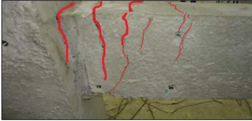
Şekil 4.81. S9 deney elemanında meydana gelen çatlak gelişimi
