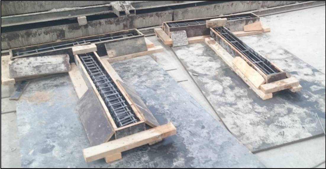
Şekil 3.9. Donatıların kalıp içine yerleşimi
