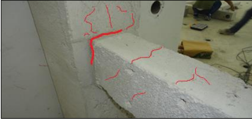
Şekil 4.18. S2 deney elemanında meydana gelen çatlak gelişimi
