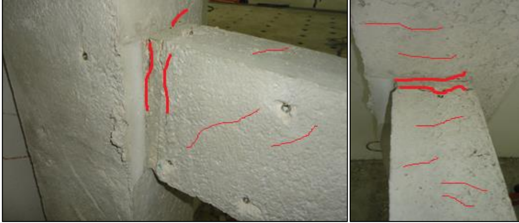
Şekil 4.27. S3 deney elemanında meydana gelen çatlak gelişimi
