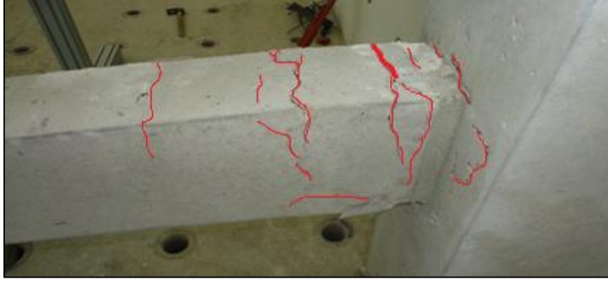
Şekil 4.99. S11 deney elemanında meydana gelen çatlak gelişimi
