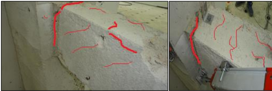
Şekil 4.36. S4 deney elemanında meydana gelen çatlak gelişimi
