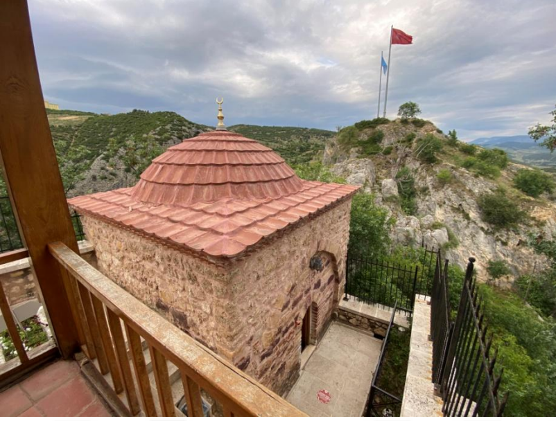
EK III: Malhun Hatun Türbesi Dış Görünüş.
