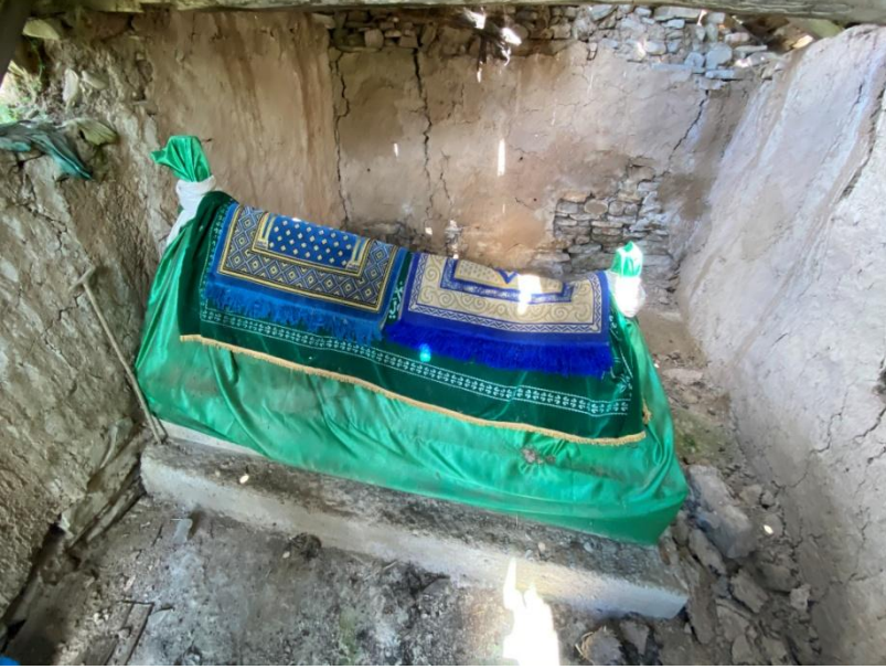
EK LXXIV: Selim Dede Türbesi İç Görünüş.
