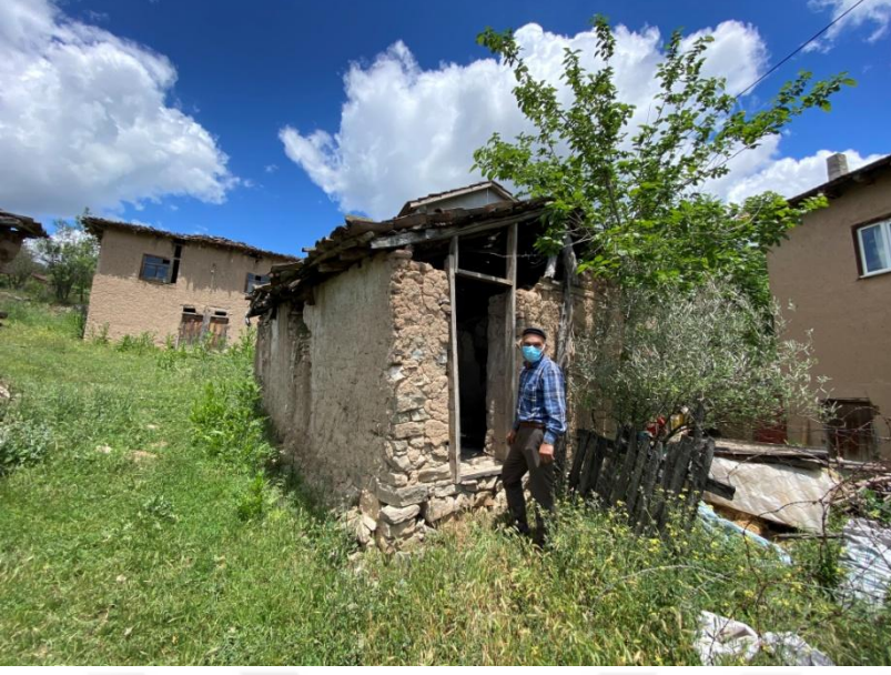
EK LXXIII: Selim Dede Türbesi Dış Görünüş.
