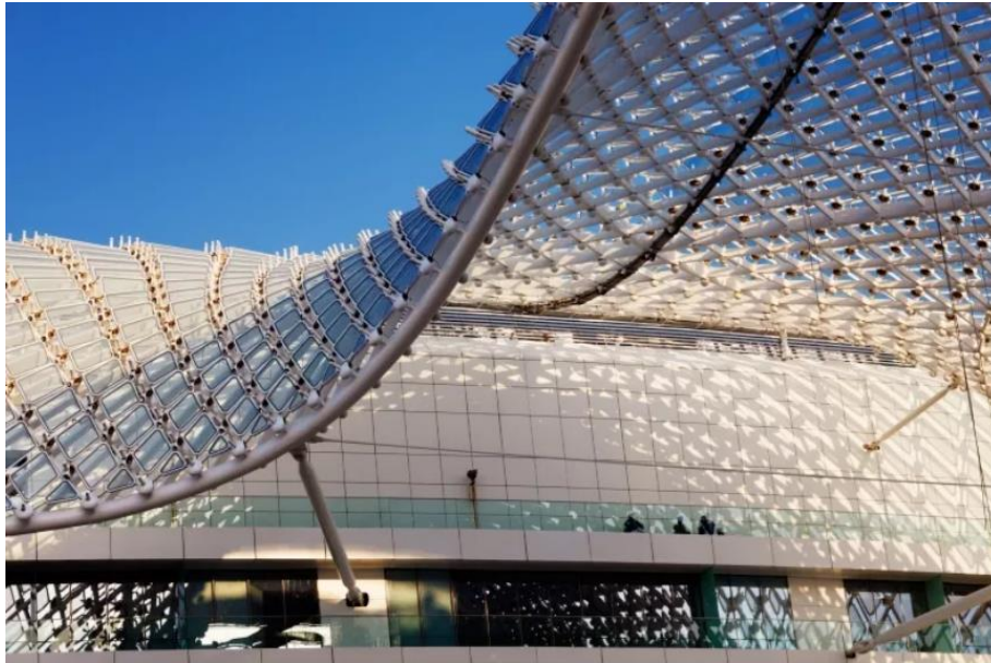
Şekil 1.5. Yapısal uygulamalarda boru tüp kullanımı
