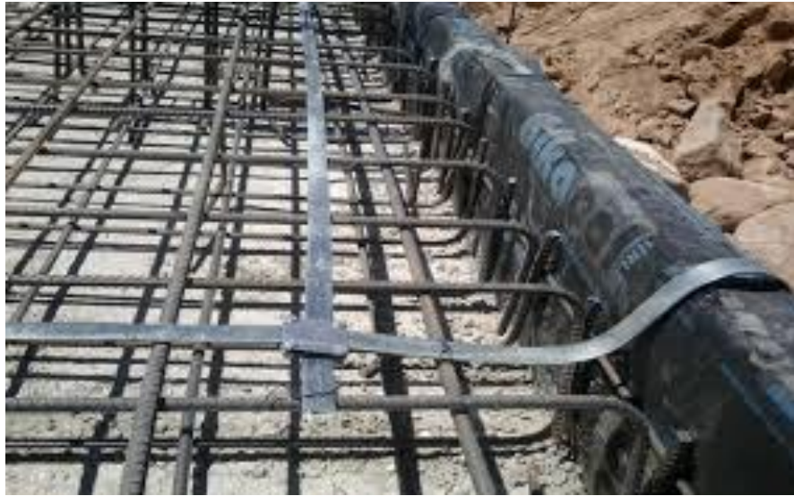
Şekil 2. 9. Temel topraklaması(www.netlobi.com).
