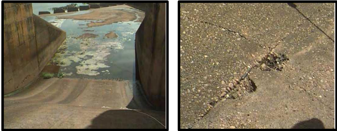
Şekil 1.1. Bir dolusavak yapısında meydana gelen aşınmalar (Galvao, vd., 2012)
