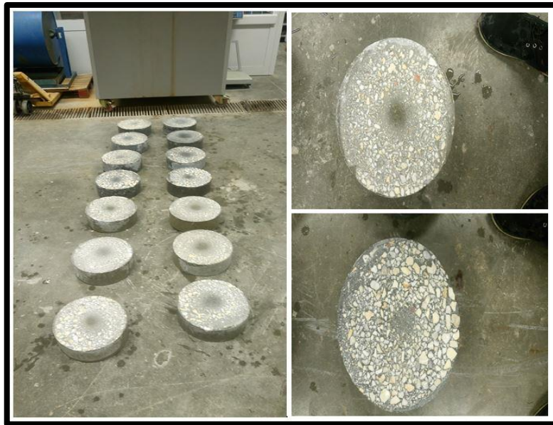
Şekil 6.10. Sualtı aşınma deneyi sonucunda aşınan beton yüzeyleri
