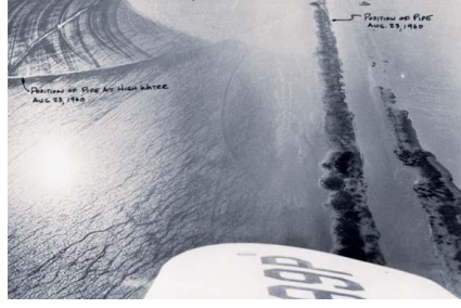
Şekil 4.5. Sıvılaşma sonucu borunun zemine yüzeyine çıkması
