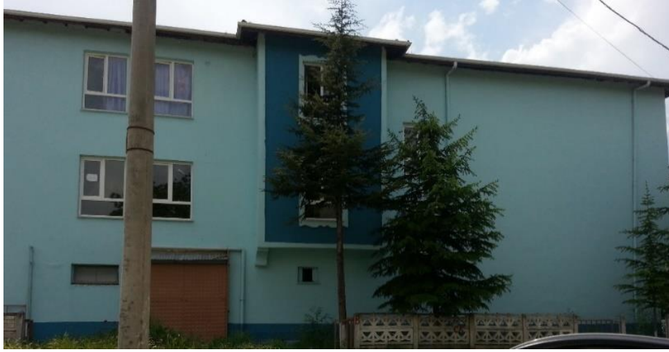
Şekil 5.15. Okul No:3 – Arka Görünüş
