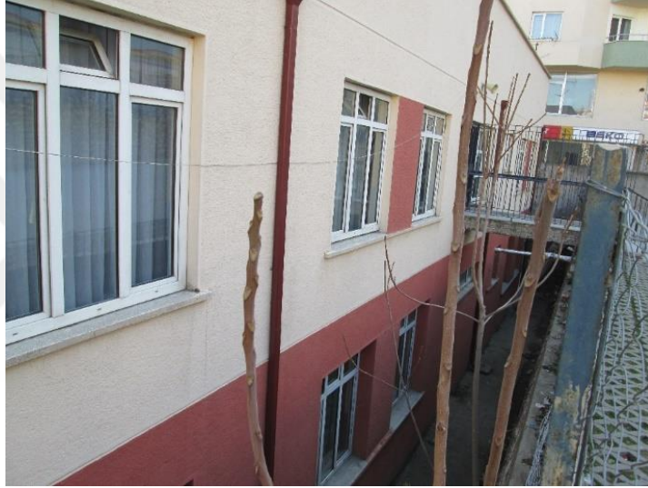
Şekil 5.2. Okul No:1 – Arka Görünüş
