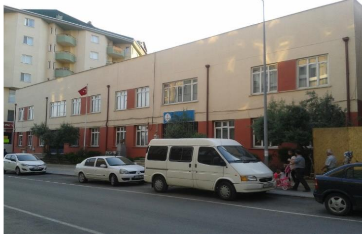
Şekil 5.1. Okul No:1 – Ön Görünüş
