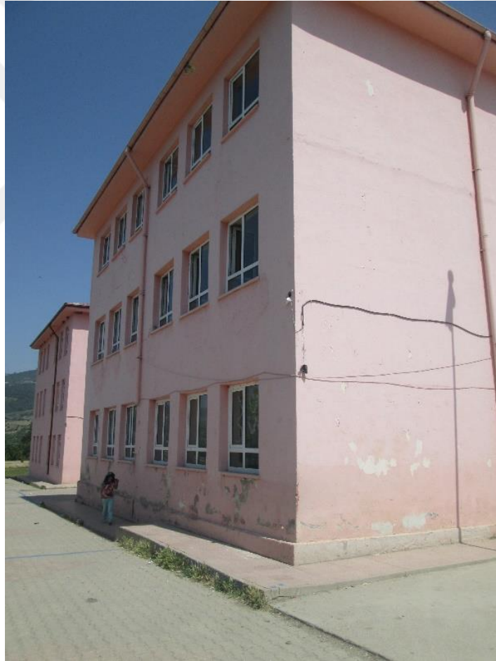
Şekil 5.8. Okul No:2 – Arka Görünüş
