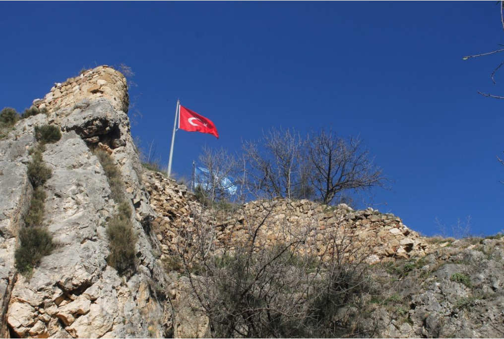
Ek-46: Bilecik-Kalesi Sur Duvarları.
