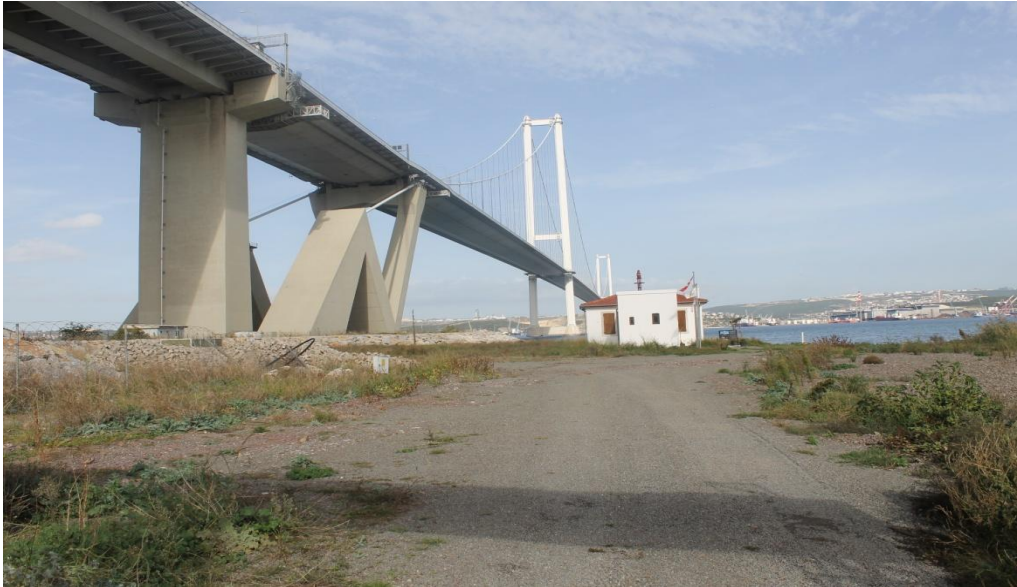
Şekil-3.19. Yalova-Hersekburnu ve Osman Gazi Köprüsü.
