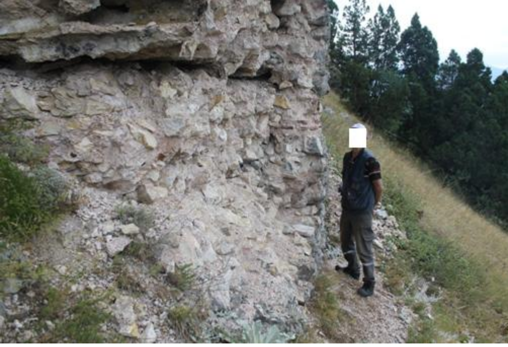
Ek-73: Bursa-İnegöl-Bedre(Çayyaka)Köyü Kalesi Sur Duvarları.
