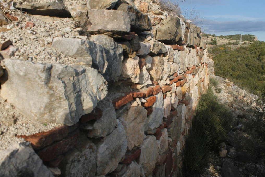
Ek-48: Bilecik-Kalesi Sur Duvarları.
