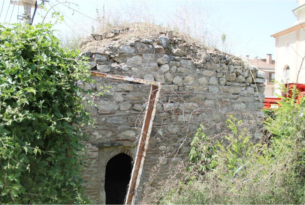
Ek-133: Bursa-Yenişehir-Köprühisar Hamamı.
