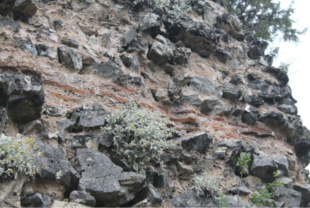
Ek-74: Bursa-İnegöl-Bedre (Çayyaka) Köyü Kalesi Sur Duvarları.
