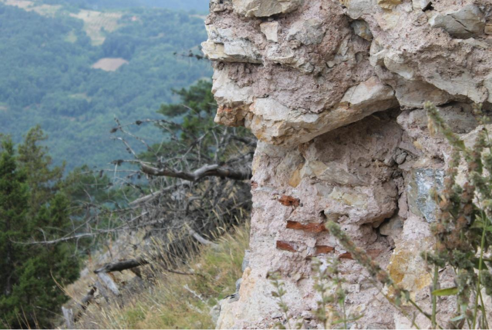
Ek-72: Bursa-İnegöl-Bedre(Çayyaka)Köyü Kalesi Sur Duvarları.
