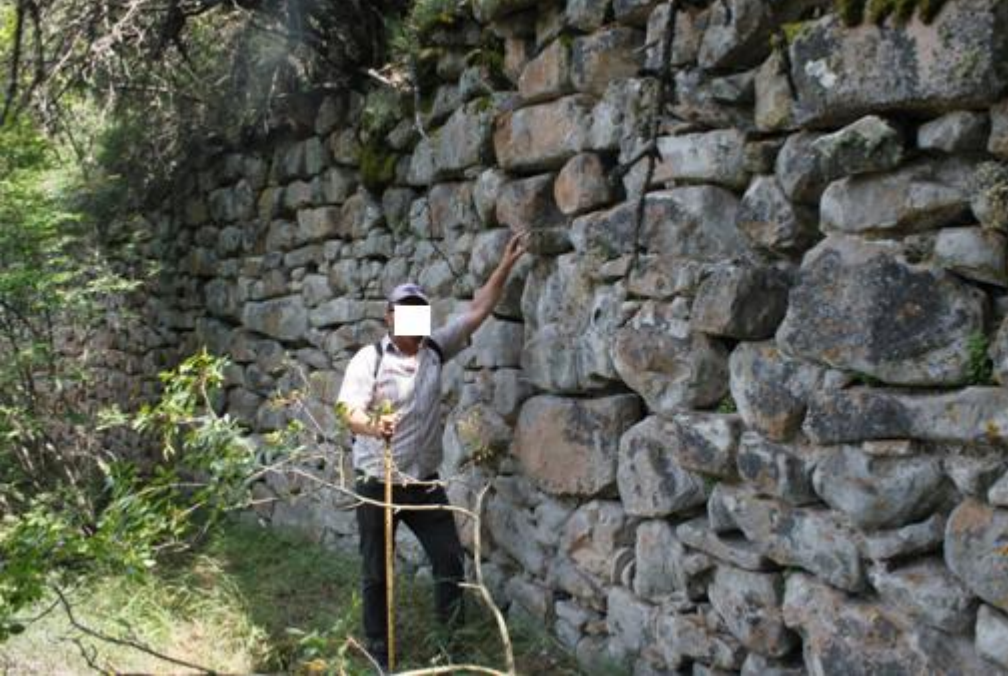
Ek-146: Eskişehir-Mihalgazi-Bozaniç Kalesi Duvarları.
