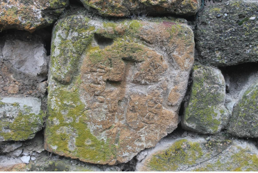
Ek-1: Ankara-Beypazarı-Hırkatepe Köyü Ev Duvarı.
