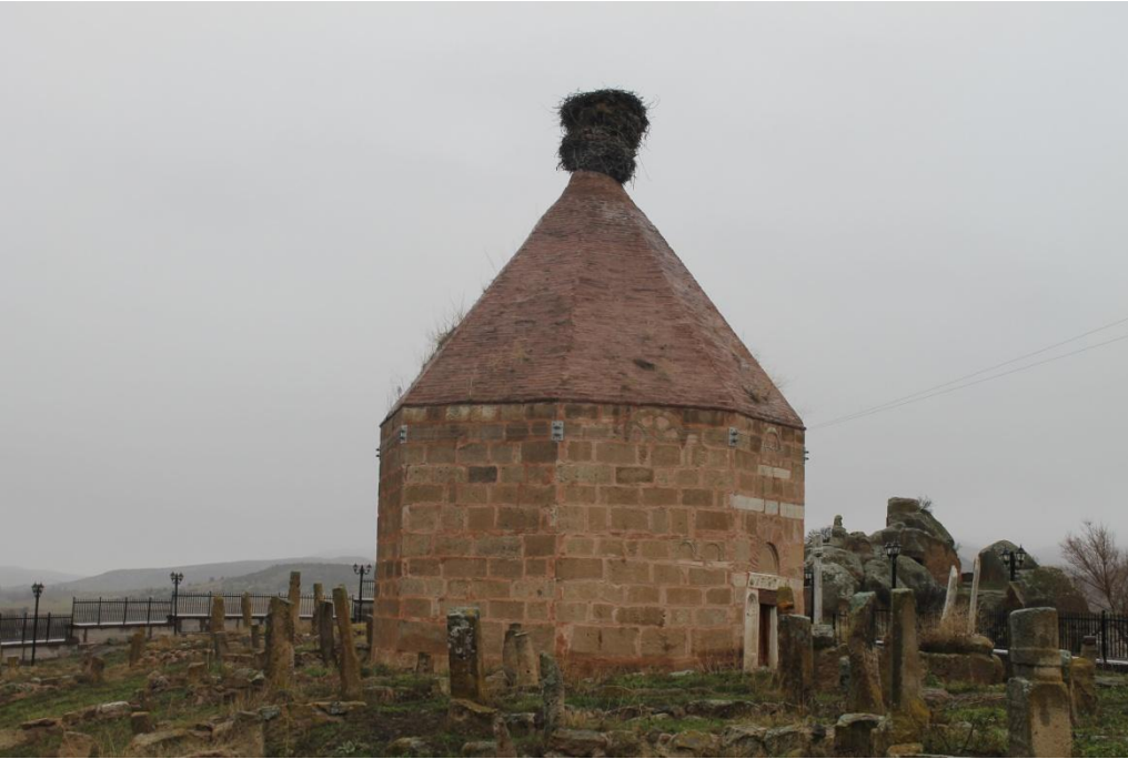
Ek-149: Eskişehir-Seyitgazi-Kümbet Köyü-Himmet Baba Türbesi.
