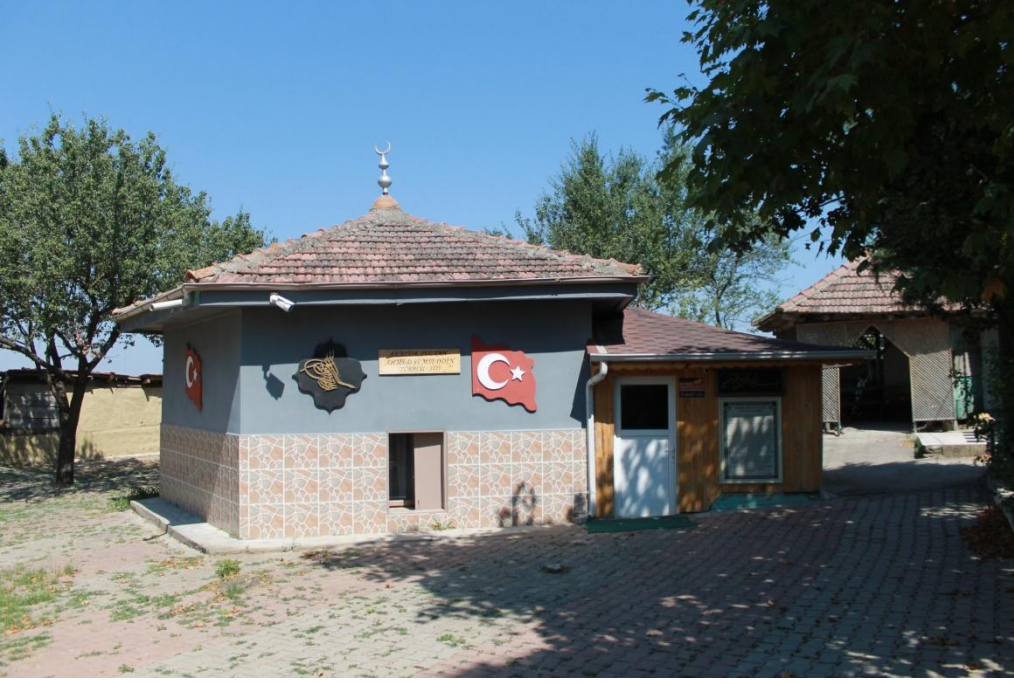
Ek-81: Bursa-İnegöl-Tekkeköy Akbıyık Türbesi.
