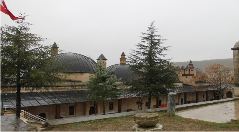
Şekil-1.4. Eskişehir-Seyitgazi-Seyit Battal Gazi Külliyesi.
