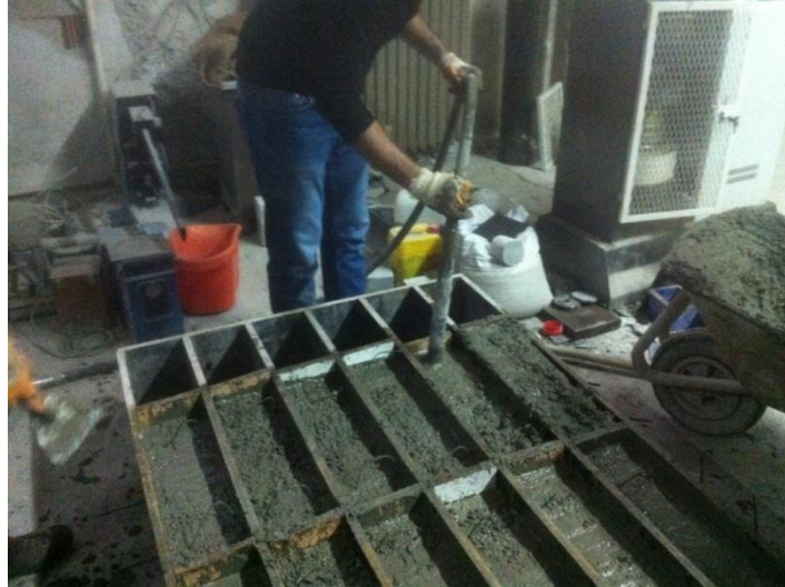
Şekil 3.16. Deney elemanlarının beton dökümü ve sıkıştırılması.
