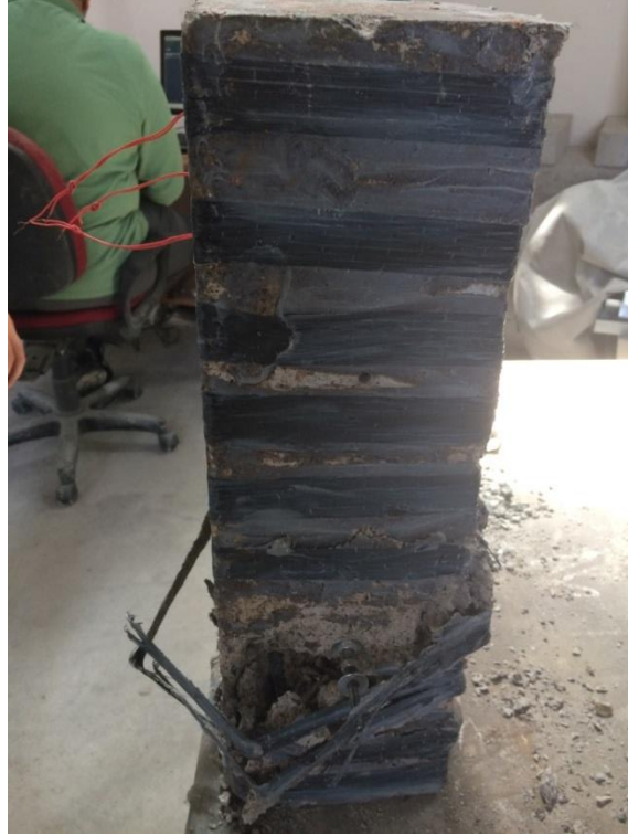
Şekil 4.21. Deney elemanı-7 alt ucundaki CFRP şeritlerin kopması sonucunda göçmesi.
