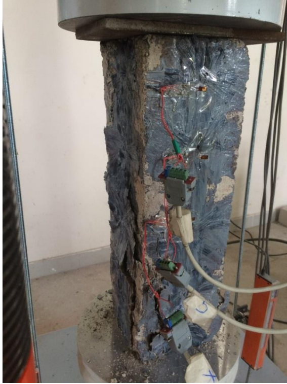
Şekil 4.33. Deney elemanı-11 CFRP şeridin yüzeyden soyulması sonucunda göçmesi.
