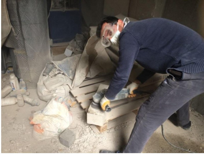
Şekil 3.19. CFRP yapışma yüzeylerinin taşlanması.
