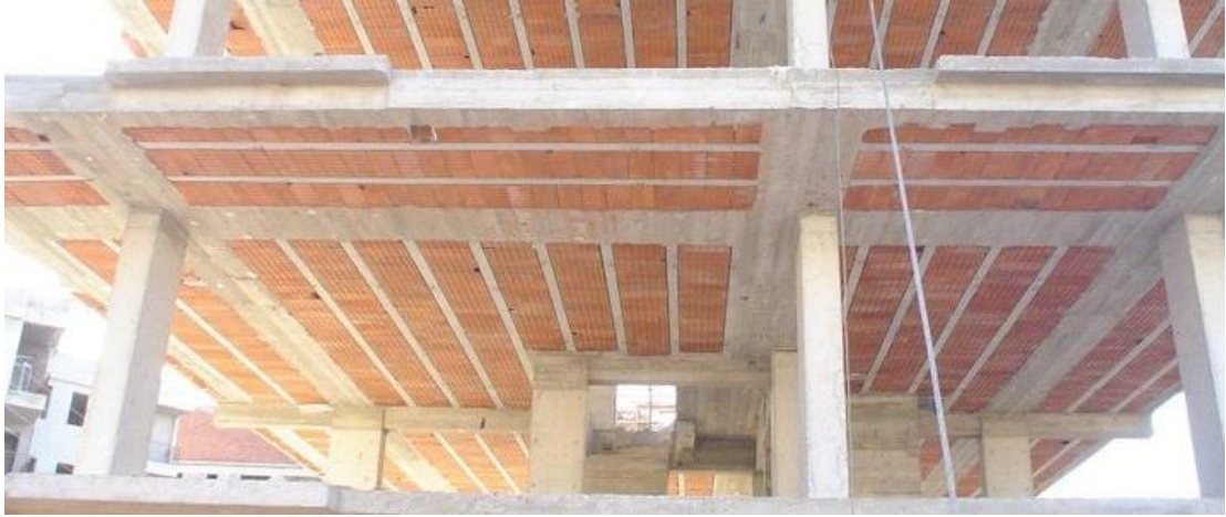
Şekil 3.9. Asmolen döşeme kat planı (Topçu, 2018).
