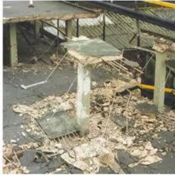
Şekil 4.4. Kirişsiz döşemede zımbalama etkisi örneği (URL-6).
