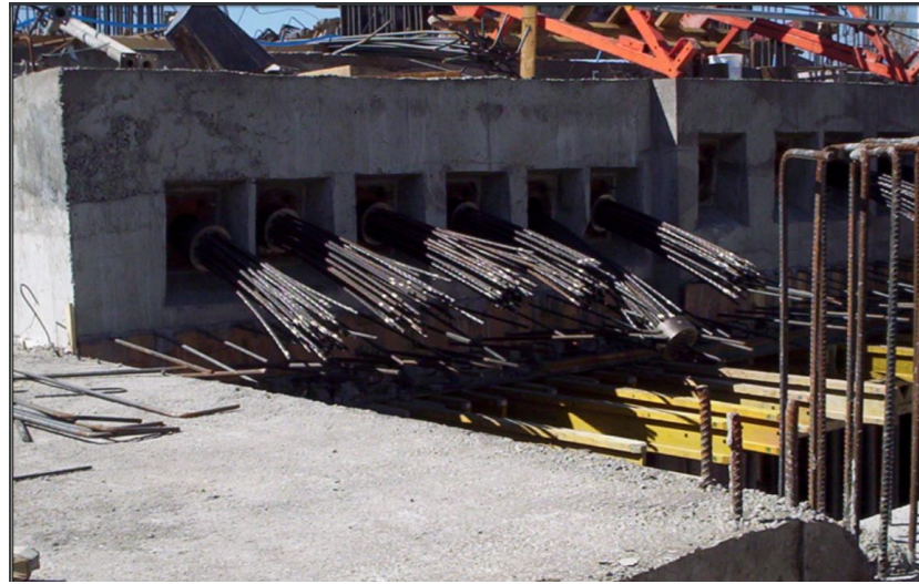
Şekil 4.12. Ardgerme yapılacak halatlar (URL-3).
