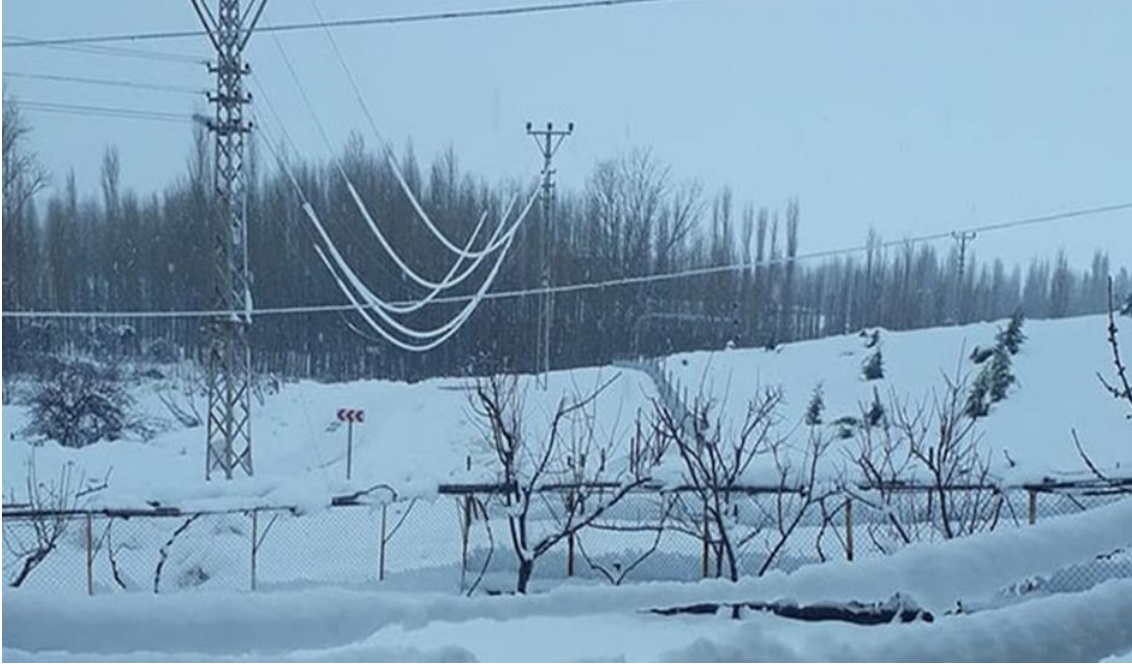
Şekil 4.32. Kar yağışından bağlı olarak hat kopma arızaları
