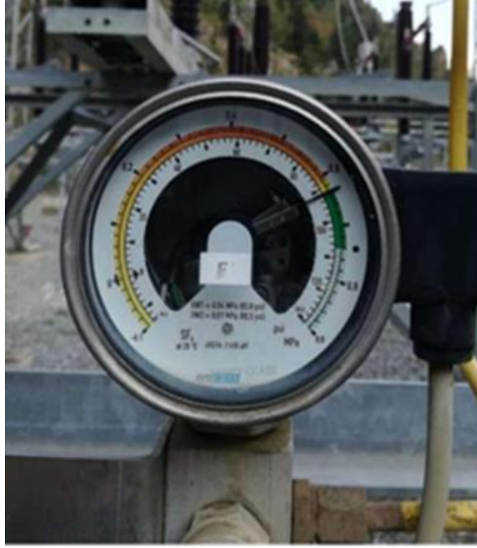
Şekil 4.21. Sf6 gaz manometre, Sf6 gaz yoğunluğu göstergesi
