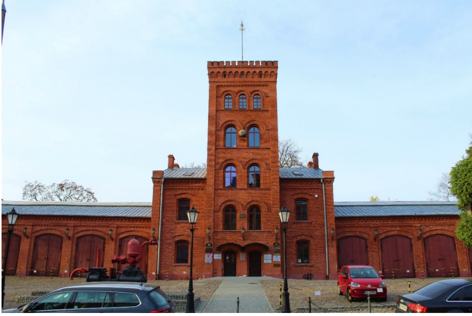
Şekil 8.35. Yenilenen itfaiye binası
