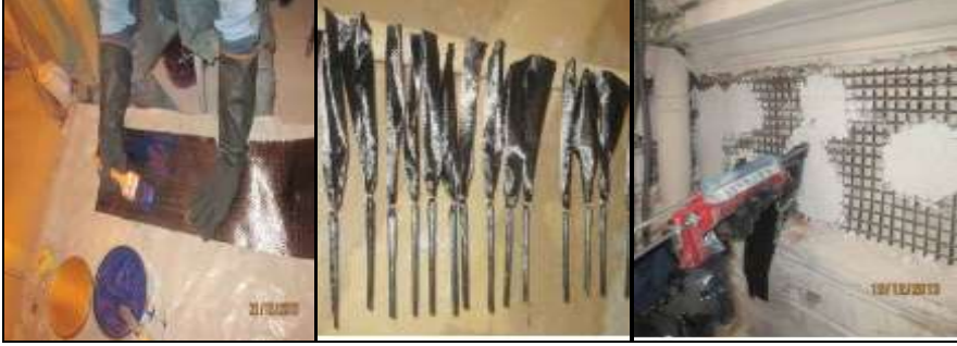
Şekil 6: Ankraj Aşamaları
