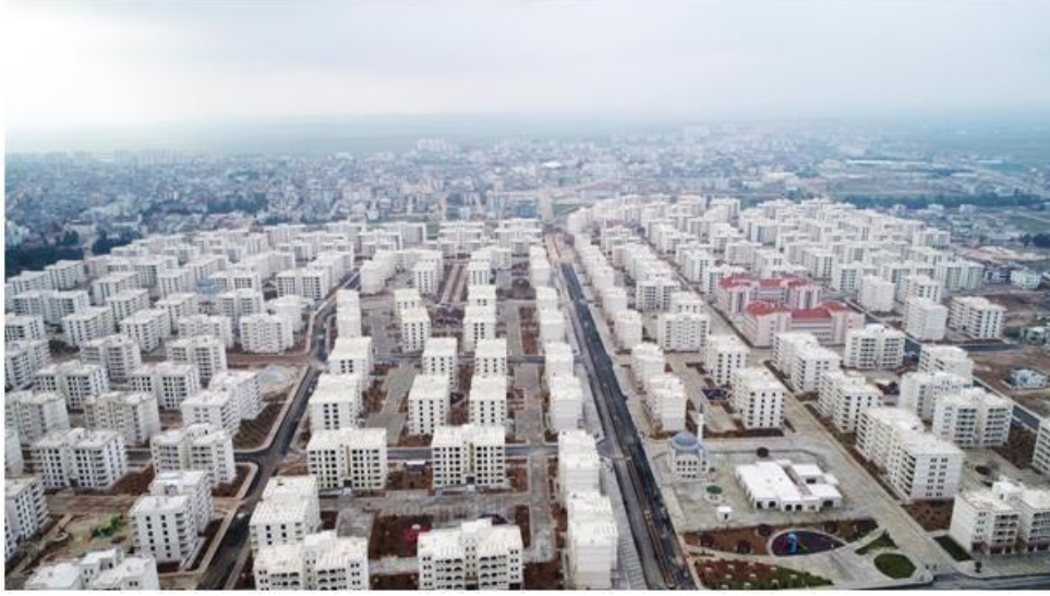
Şekil 3.10. Abdulkadirpaşa ve Fırat Mahallesinde Toplu Konutlar
