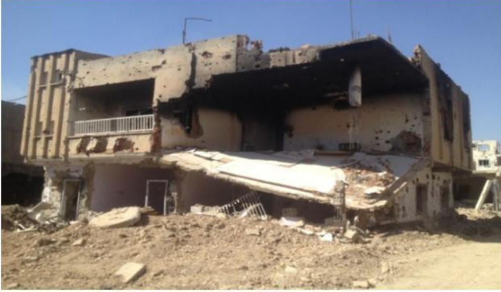
Şekil 3.8. Hendek Operasyonlarından hasar gören bir konut
