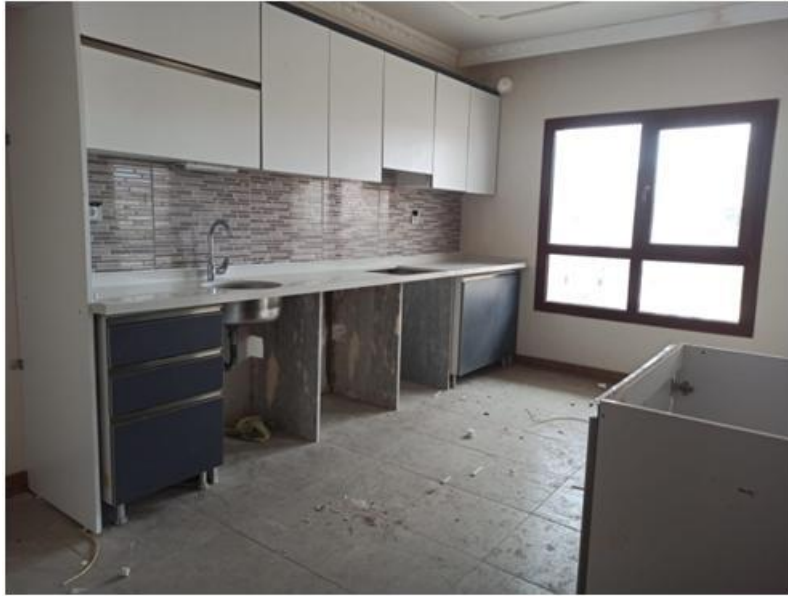
Şekil 4.9. Suntadan yapılan mutfak dolapları ve tezgâhın değişim ve tadilatı
