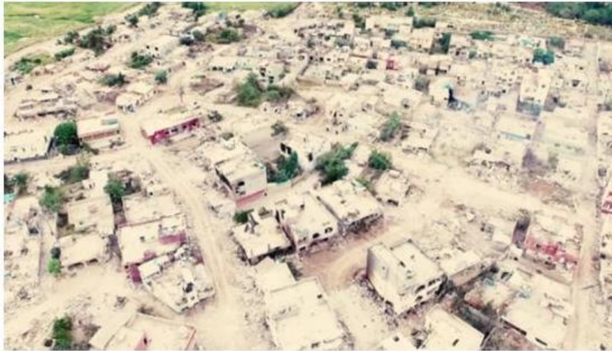
Şekil 3.7. Zeynelabidin Mahallesinde kentsel dönüşümden önce hasarlı olan evler
