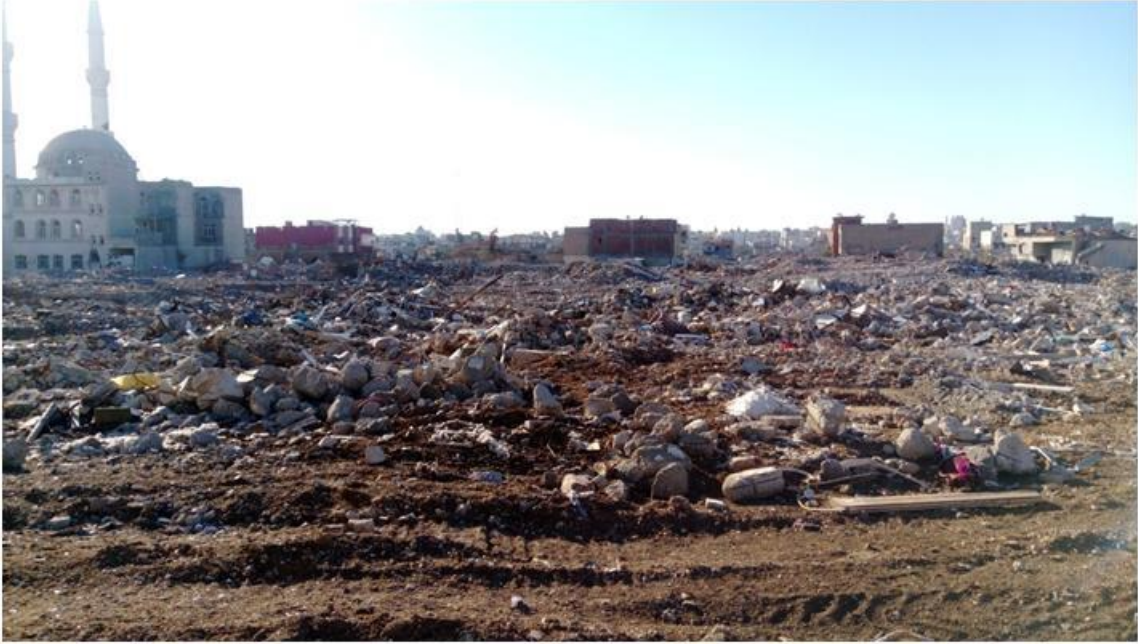
Şekil 4.11. Şehrine dönen insanlar, yıkık ve hasar almış mahallelerin manzarası ile karşılaşmıştır (Abdulkadirpaşa Mahallesi)
