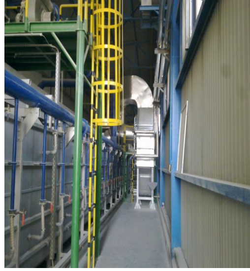
Şekil 7.7. Fırın 6 atık ısı ekonomizeri.
