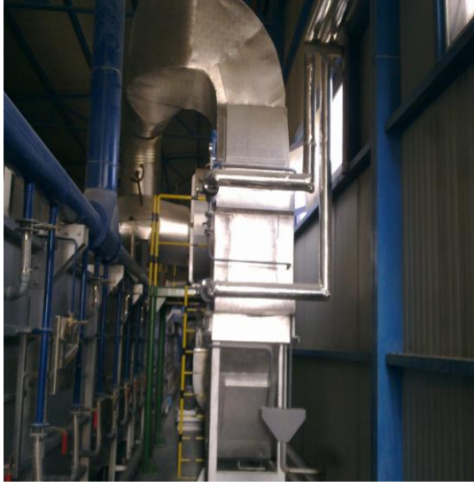
Şekil 7.6. Fırın 5 atık ısı ekonomizeri
