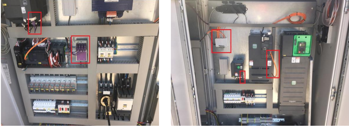
Şekil 8.18. Sistemde kullanılan sürücü modelleri ve haberleşme bağlantıları
