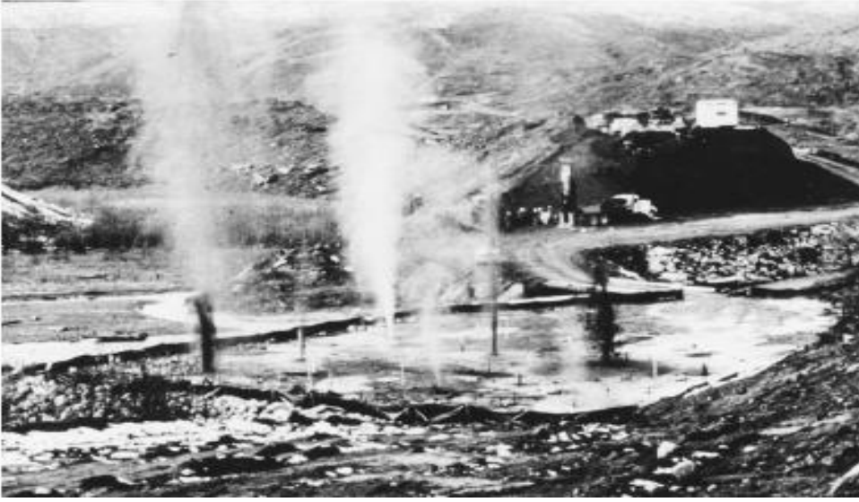
Şekil 3.12. Köprü İnşasından Önce Abatman Altındaki Gevşek Zeminin Patlatma İle Sıkıştırılması
