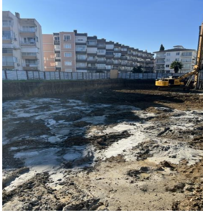
Şekil 5.10. Deniz Seviyesindeki Konut İnşaatı Temelinde Uygulanan DSM Kolonları
