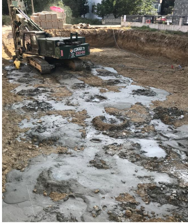
Şekil 3.22. Konut İnşaatında Uygulanan Temel Altı Zemin Karıştırma İşlemi Uygulaması (Yalova,2021)
