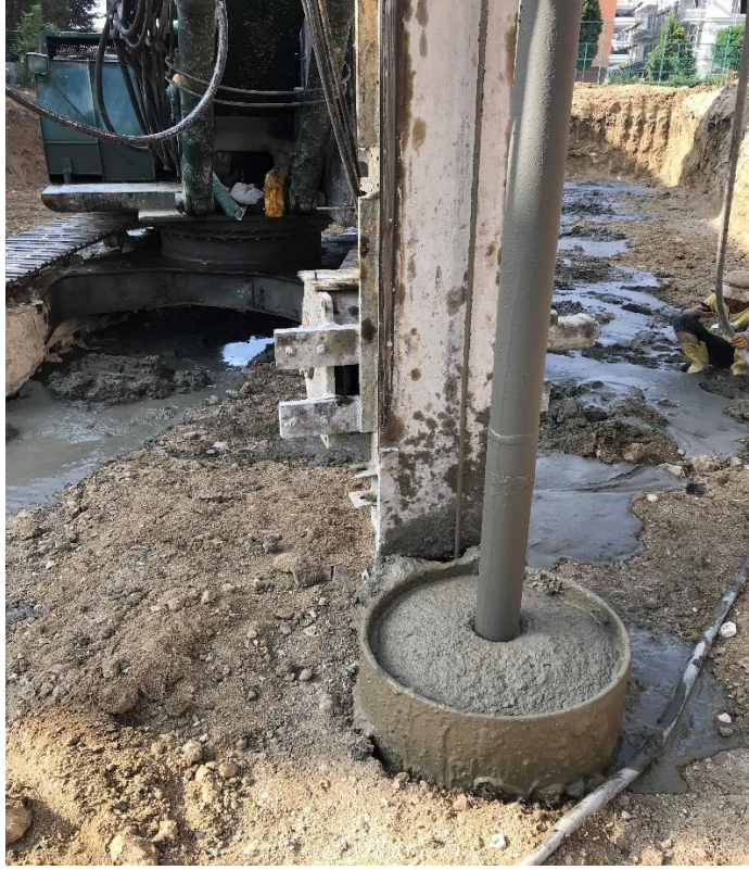
Şekil 3.21. Konut İnşaatında Uygulanan Temel Altı Zemin Karıştırma İşlemi Uygulaması (Yalova,2021)
