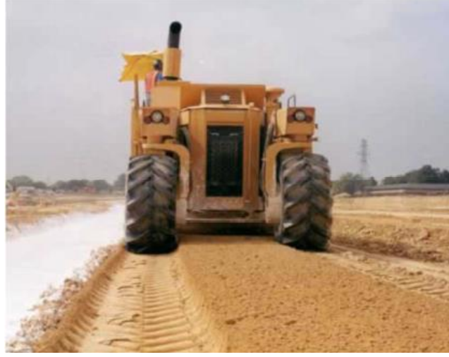
Şekil 3.6. Kireç Stabilizasyonu Uygulaması
