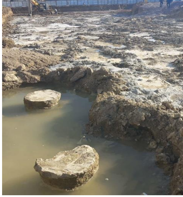
Şekil 5.9. Deniz Seviyesindeki Konut İnşaatı Temelinde Uygulanan DSM Kolonları
