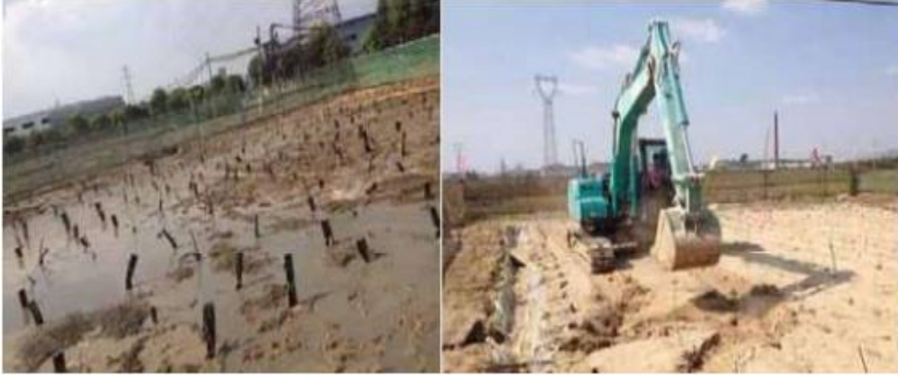
řekil 3.24. Elektro Osmoz Uygulamasının Öncesi Ve Sonrası
