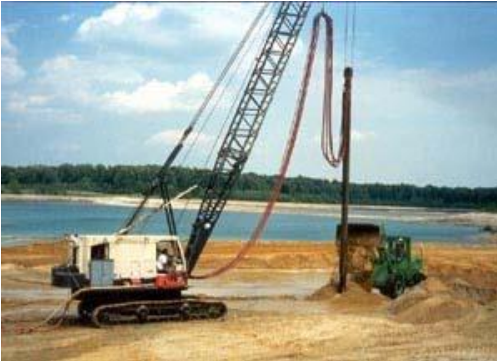
Şekil 3.8. Vibrokompaksiyon Uygulaması
