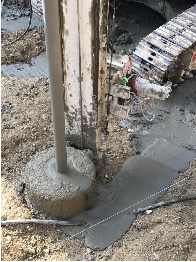
Şekil 3.20. Konut İnşaatında Uygulanan Temel Altı Derin Karıştırma İşlemi Enjeksiyon Malzemesi (Yalova,2021)
