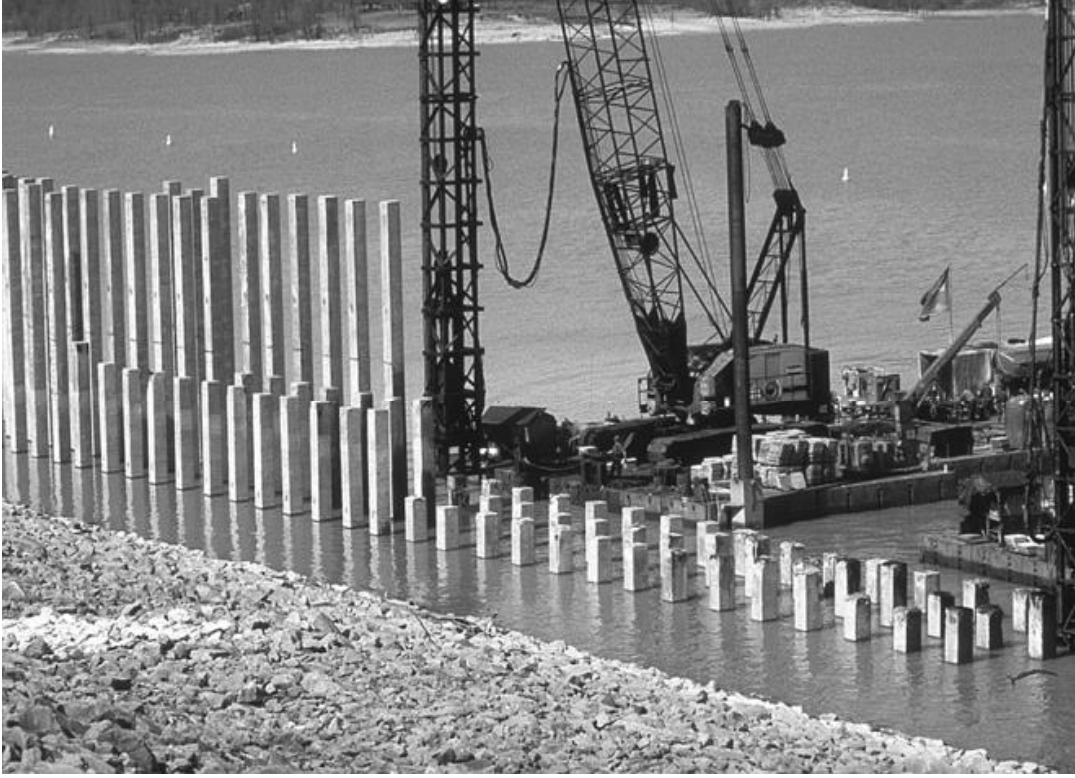
Şekil 3.10. Sardis Barajı Dolgusunun Memba Yüzeyine Çakılan Kompaksiyon Kazıkları
