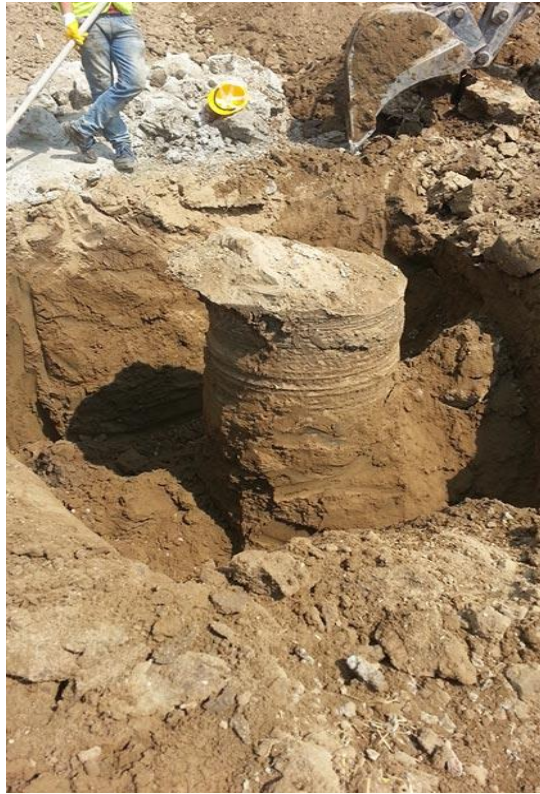
Şekil 3.23. İmalatı Bitmiş Deep Soil Mixing (DSM) Kolonu (Yalova 2021)
