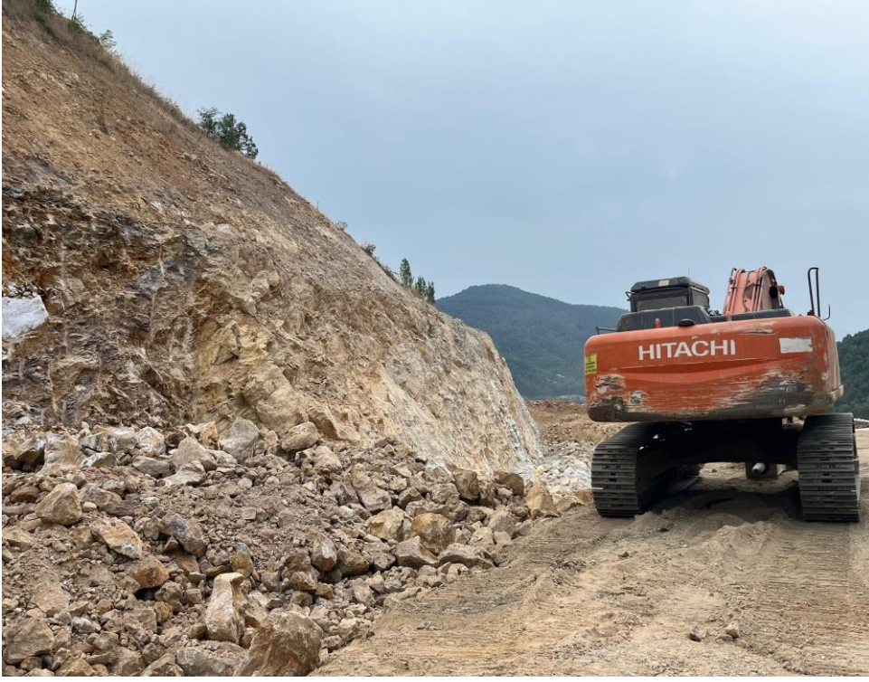
Fotoğraf 3.22. Bursa Keles yol genişletme çalışmaları (2024).
