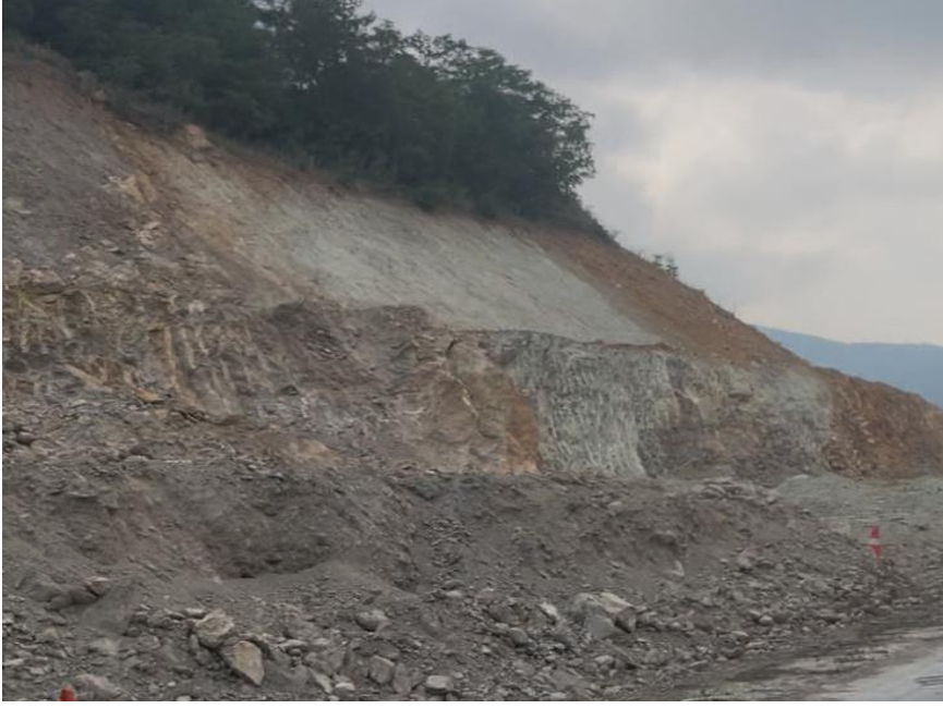
Fotoğraf 3.13. Yol kenarına yapılan teraslama çalışması (2024).
