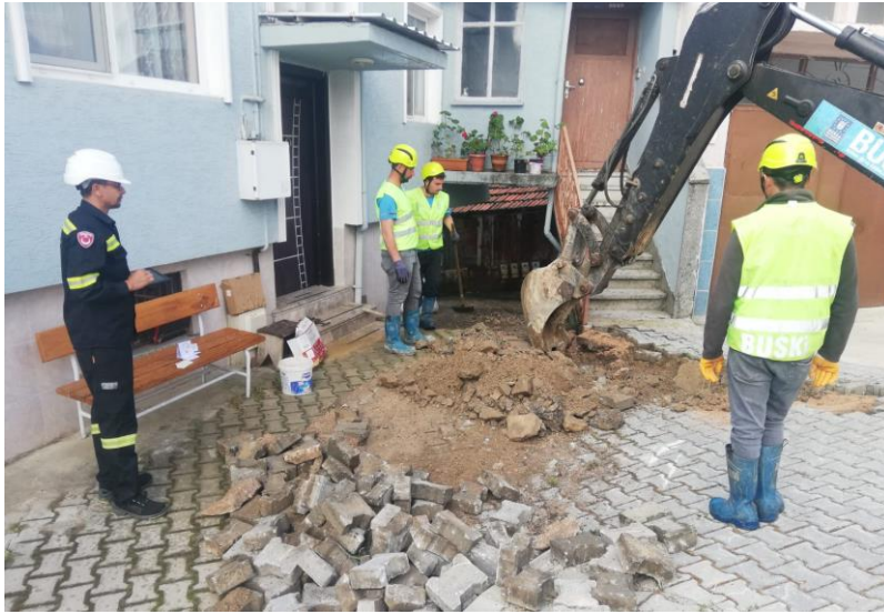
Fotoğraf 3.17. Alt yapı çalışması için kazılan alan (2025).
