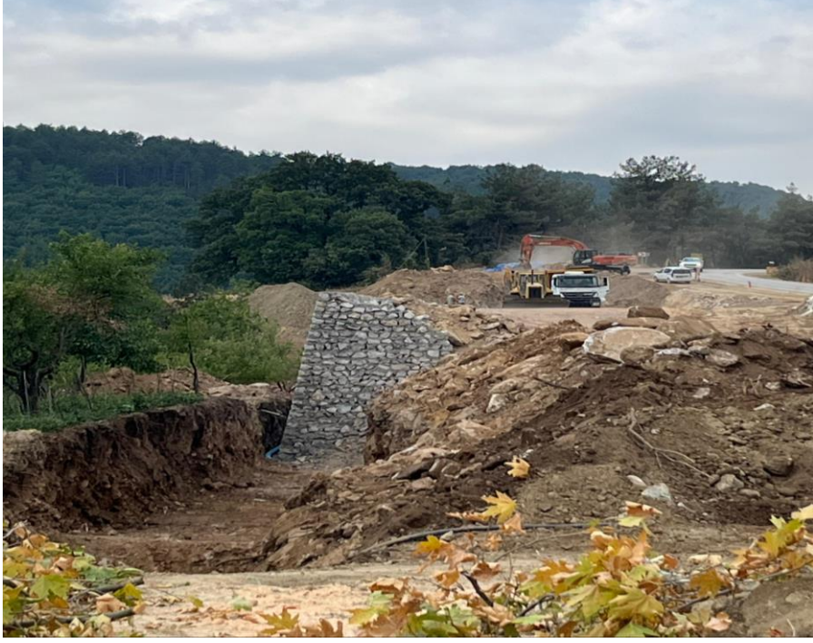
Fotoğraf 3.20. Bursa Keles, yol genişletme çalışmaları (2024).
