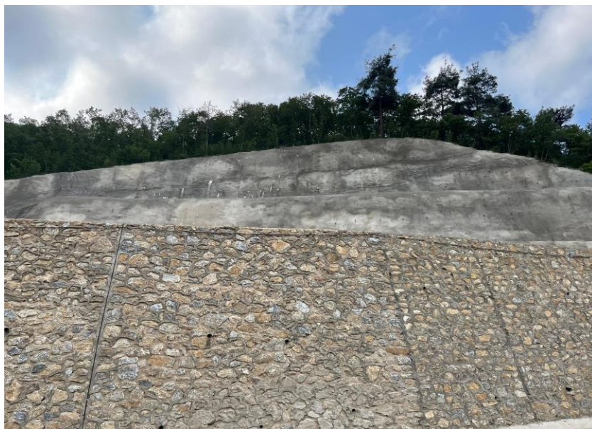
Fotoğraf 3.39. Bursa Keles yolu teraslama çalışması.
