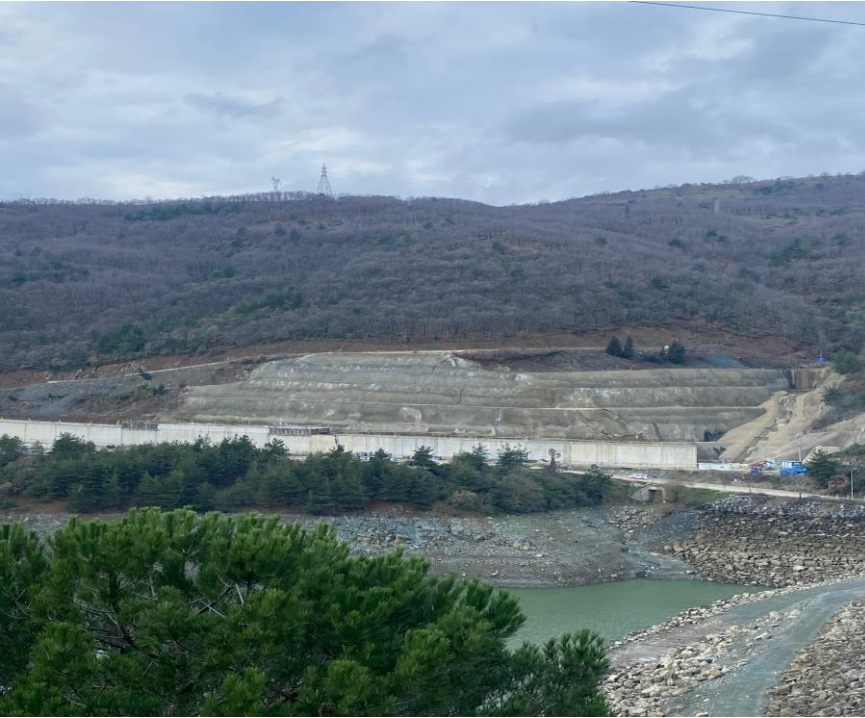
Fotoğraf 3. 14. Doğancı Barajı Üst yolunda teraslama (2024).
