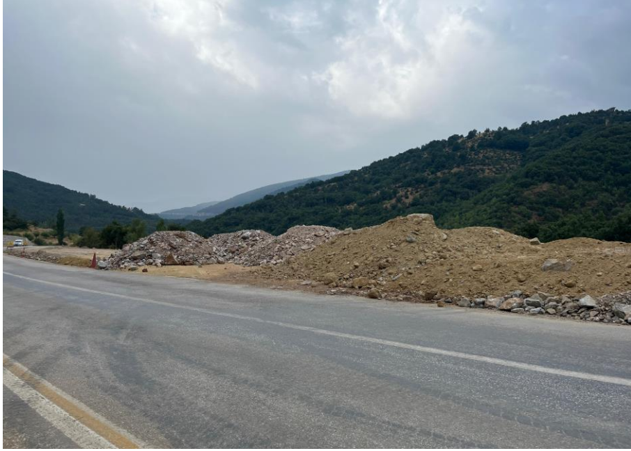
Fotoğraf 3.12. Yol yapımı esnasında dolgu amacıyla kullanılan topraklar (2024).
