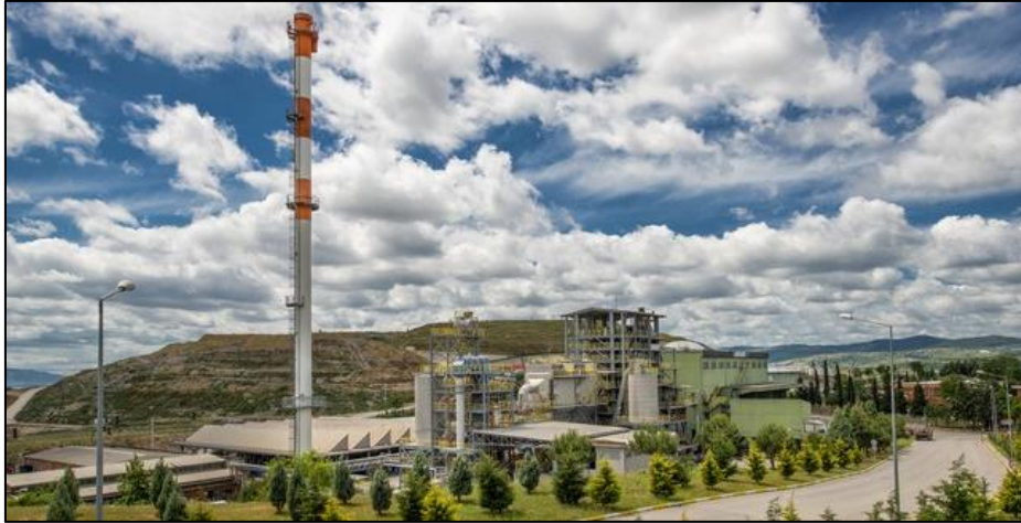
Şekil 4.1. İZAYDAŞ Geçici Depolama Alanı
