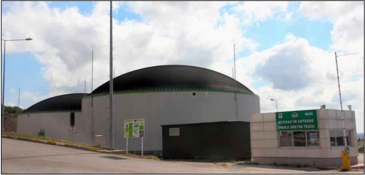
Şekil 4.7. İzaydaş Biyogaz Tesisi Kaynak: (İZAYDAŞ)
