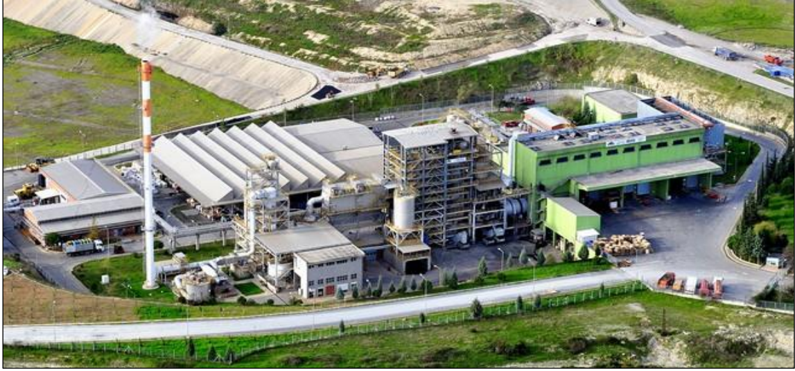
Şekil 4.3. İZAYDAŞ Tehlikeli Atık Depolama Tesisi
