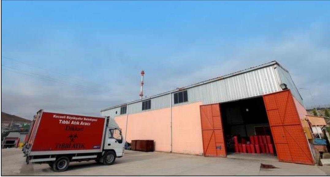
Şekil 4.8. İZAYDAŞ Sterilizasyon Tesisi
