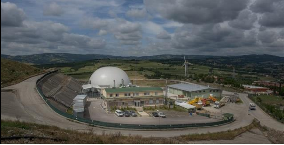
Şekil 4.10. İZAYDAŞ LFG Tesisleri
