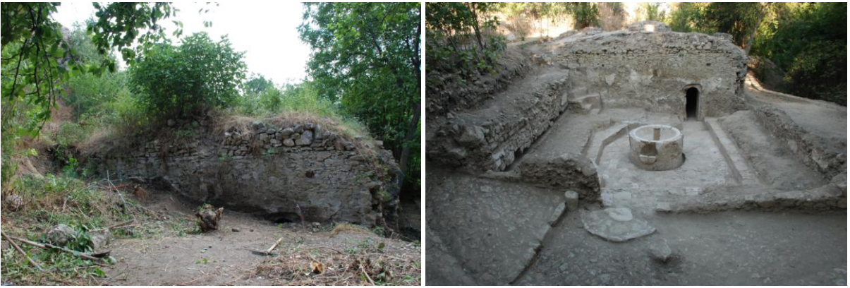
Resim 52: Süleymanpaşa Hamamı kazı öncesi ve sonrası.
