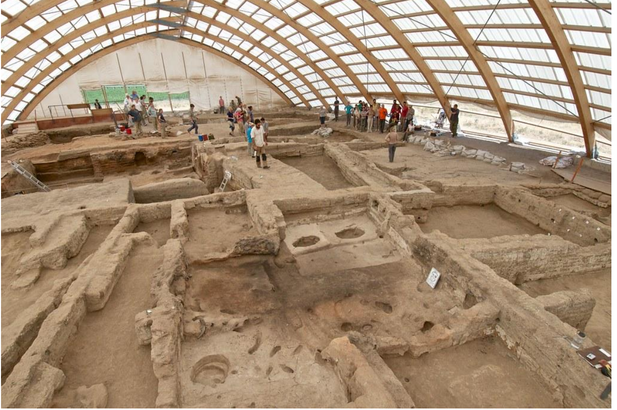
Resim 5: Çatalhöyük'te kerpiç malzemeli yapıların dış etkenlerden korunması için yapılan kalıcı örtü sistemi.
