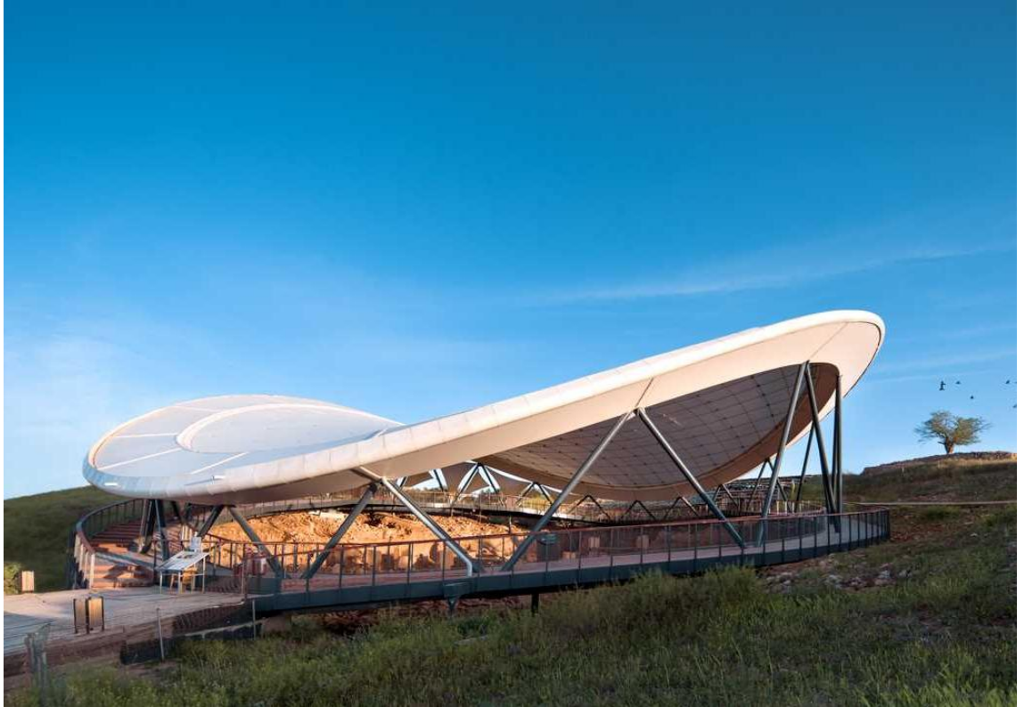
Resim 17: Göbeklitepe-1 alanı üzerindeki koruma çatısı.
