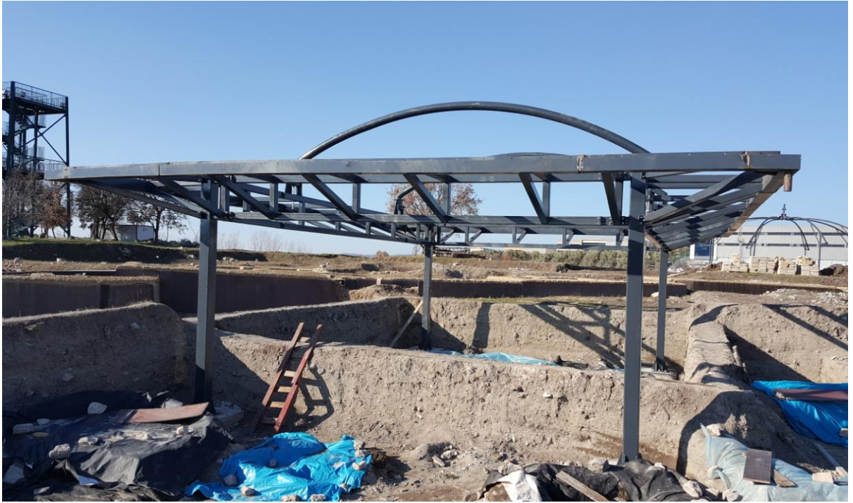
Resim 20: Üst örtü sisteminin metal iskeleti
