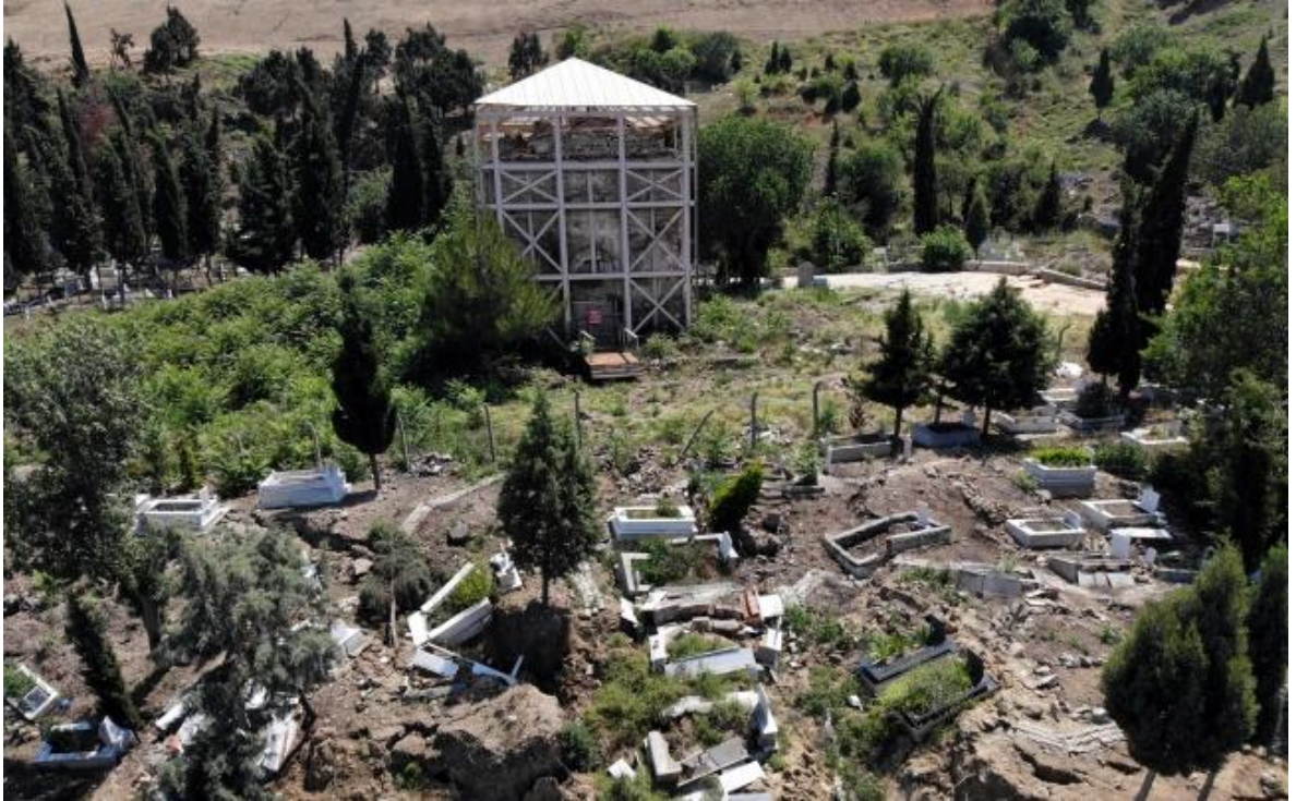
Resim 98: Orhangazi İmareti'nin olduğu alandaki toprak kayması sonucu oluşan tahribat.
