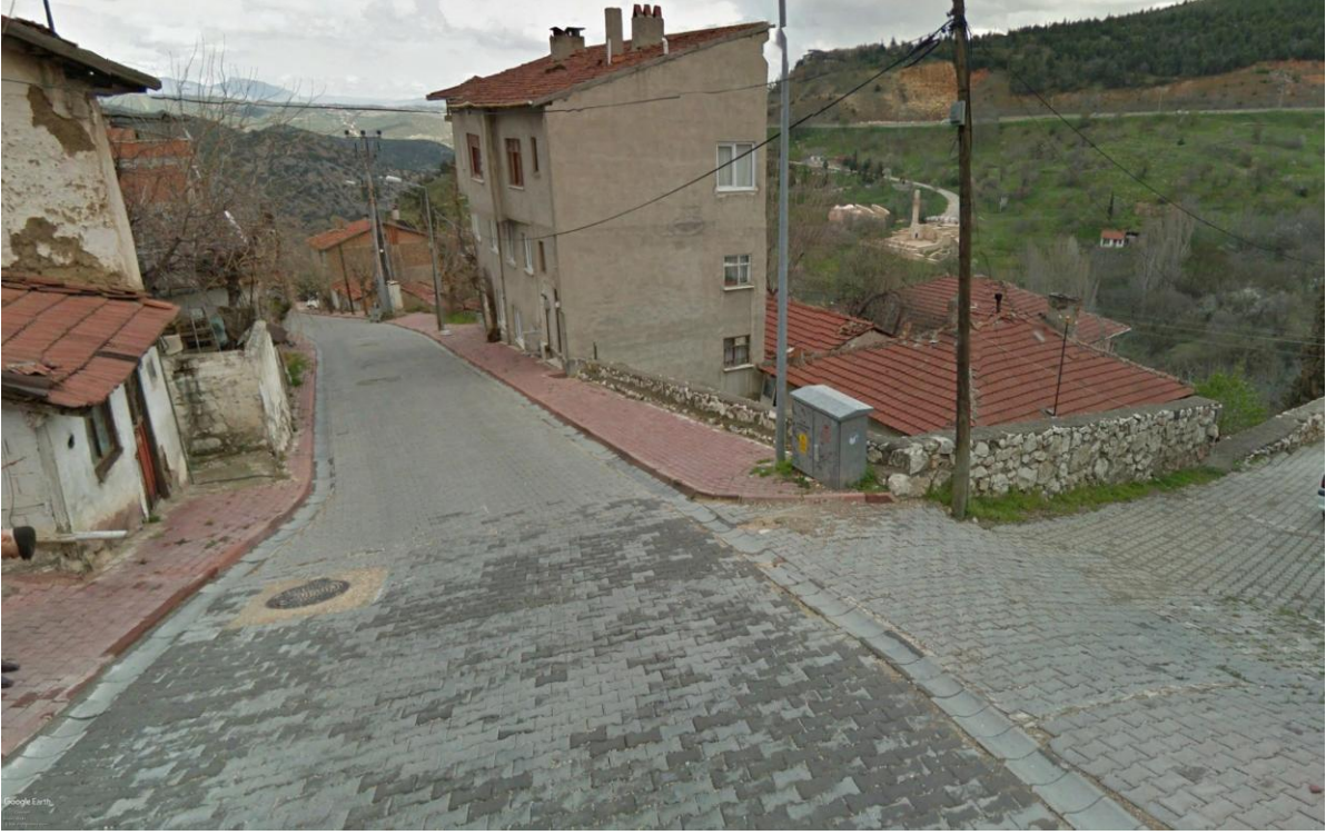
Resim 56: Konaklama ve tesis alanı şeklinde düzenlenerek öneri projesindeki Merkez İstiklal Mahallesi, 46, 47 ve 794 nolu adalarda yer alan günümüz mevcut yapıların görünümü.
