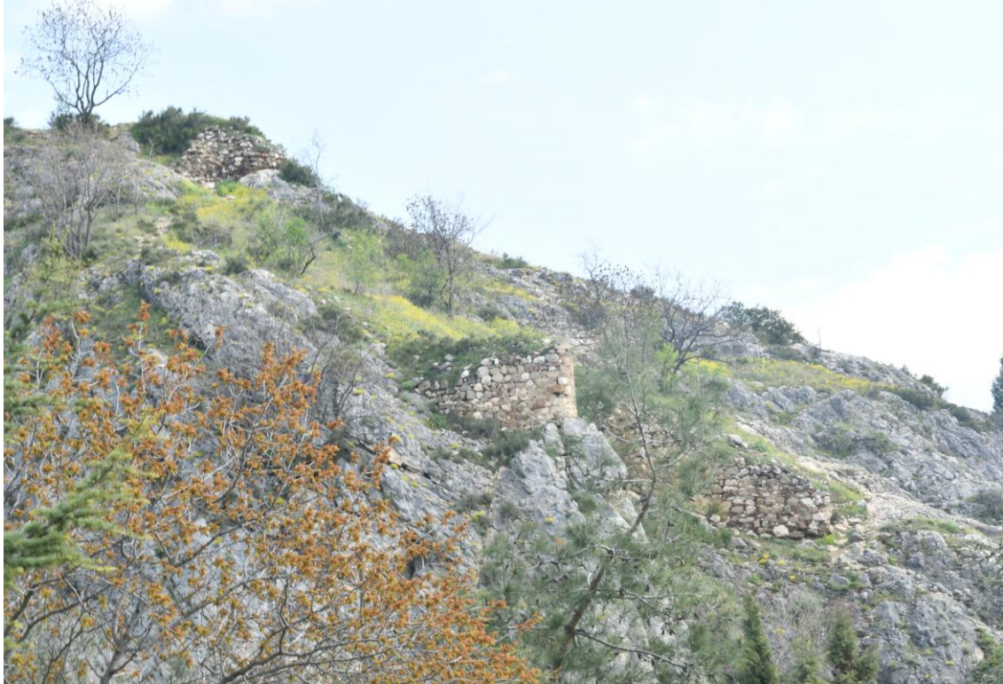
Resim 44: Belekoma Kalesi'nin günümüzdeki mevcut durumu.
