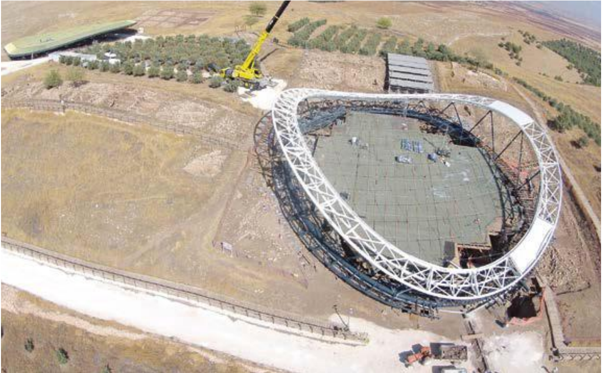
Resim 15: Eliptik semer şeklinde çatı ring makas sistemi, makas sistemi altında bulunan diagonal taşıyıcı kolon sistemi, seyir platformu ve platform altı taşıyıcı kolonlar (Göbeklitepe).
