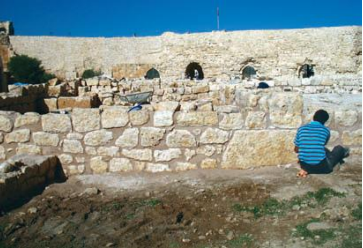
Resim 2: Mersin Kız Kalesi’ndeki kilise duvarının restorasyon çalışması.
