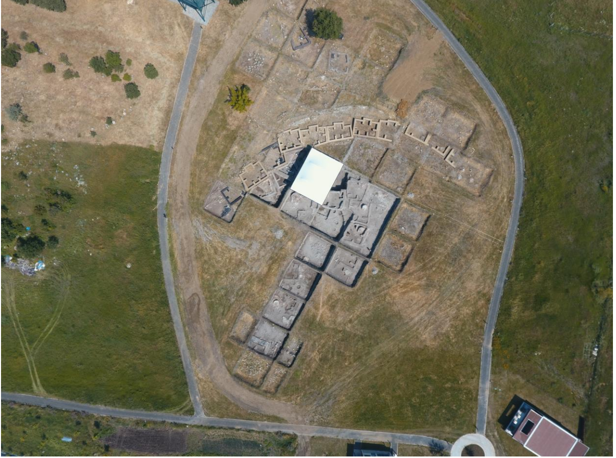
Resim 21: Höyükte B alanın, 18-I açması içindeki yapı kalıntısı üzerindeki koruma amaçlı asma-germe çatı sisteminin üstten görünümü.
