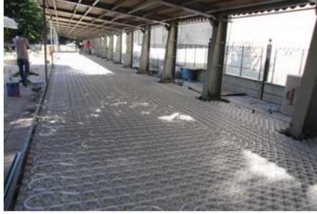
Şekil 3.7. Yüzme Havuzlarında Yerden Isıtma Sistemi
