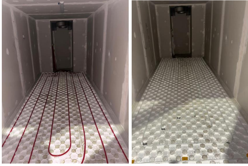
Şekil 4.8. Oxypex ve Alpex Isıtma Borusu
