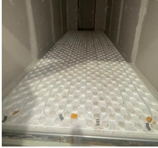
Şekil 4.9. Oxypex ve Alpex Isıtma Borusu
