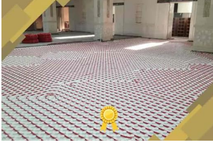
Şekil 3.3. Camilerde Yerden Isıtma Sistemi
