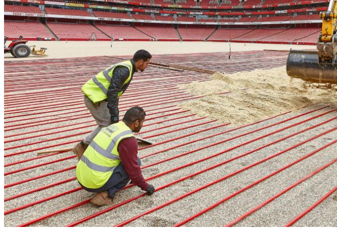
Şekil 3.4. Futbol Sahalarında Yerden Isıtma Sistemi
