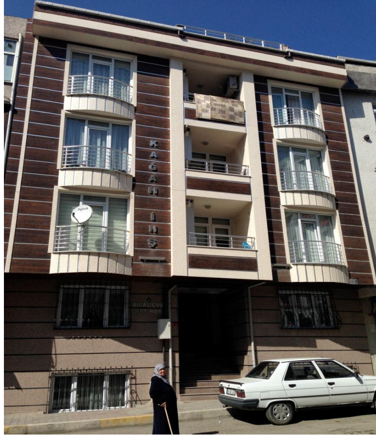
Foto 17: Proje alanı içerisinde kalan ve yıkılacak olan henüz 2 yıl önce inşa edilmiş bir bina.
