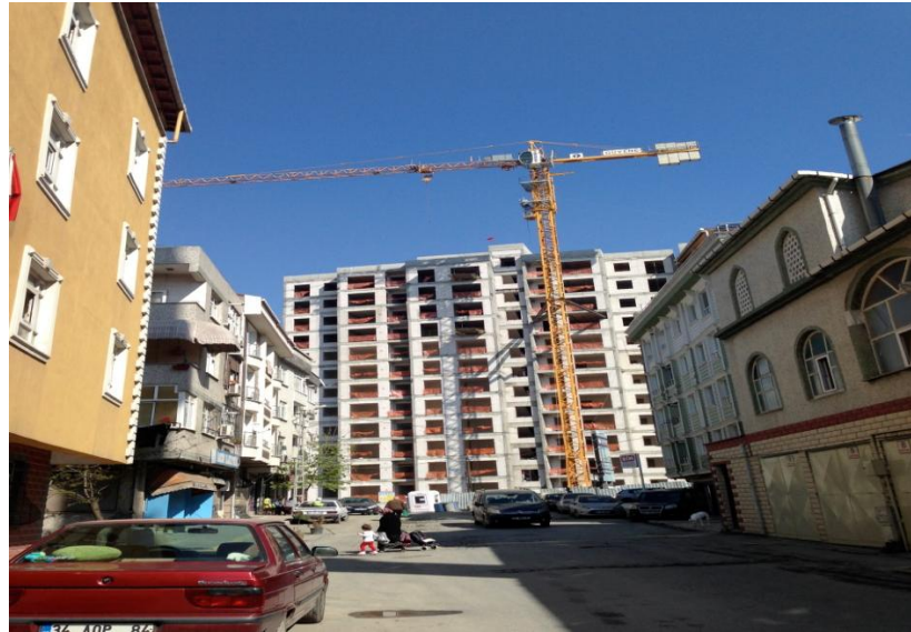
Foto 20: Yükselen ve yapım aşaması bitmek üzere olan Sarıgöl Kent Konutları
