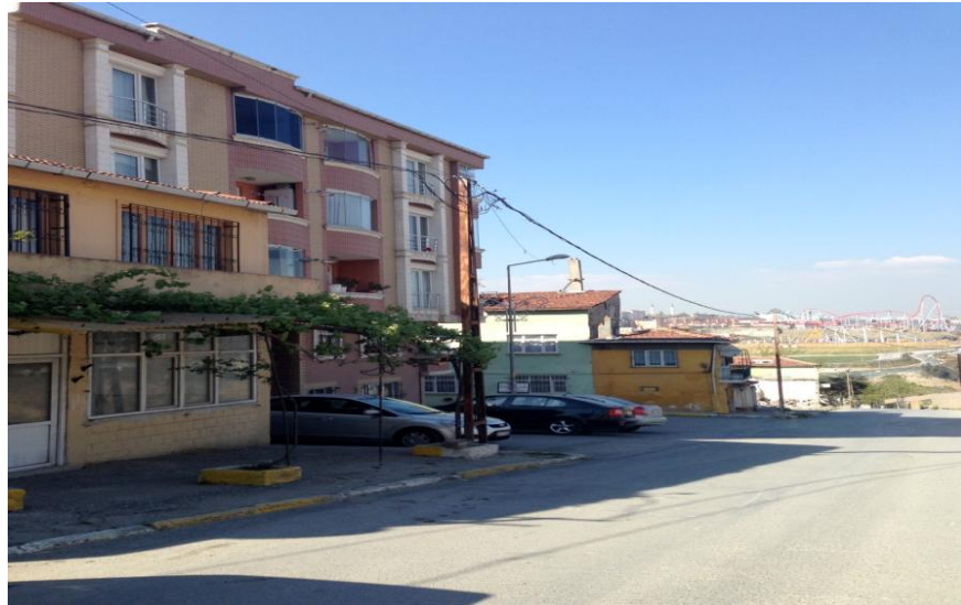
Foto 18: Kentsel dönüşüm kapsamında yıkılacak alanlarda fazla sayıda yeni bina bulunmaktadır. Yeni binalarda oturan kişiler genel olarak konutuna kentsel dönüşüme vermek istememektedir.
