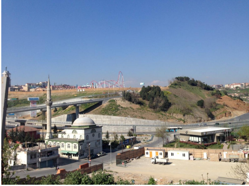
Foto 19: Yeni yapılan viyadük ve Sarıgöl Mahallesi çevresinde gelişen ulaşım sistemleri
