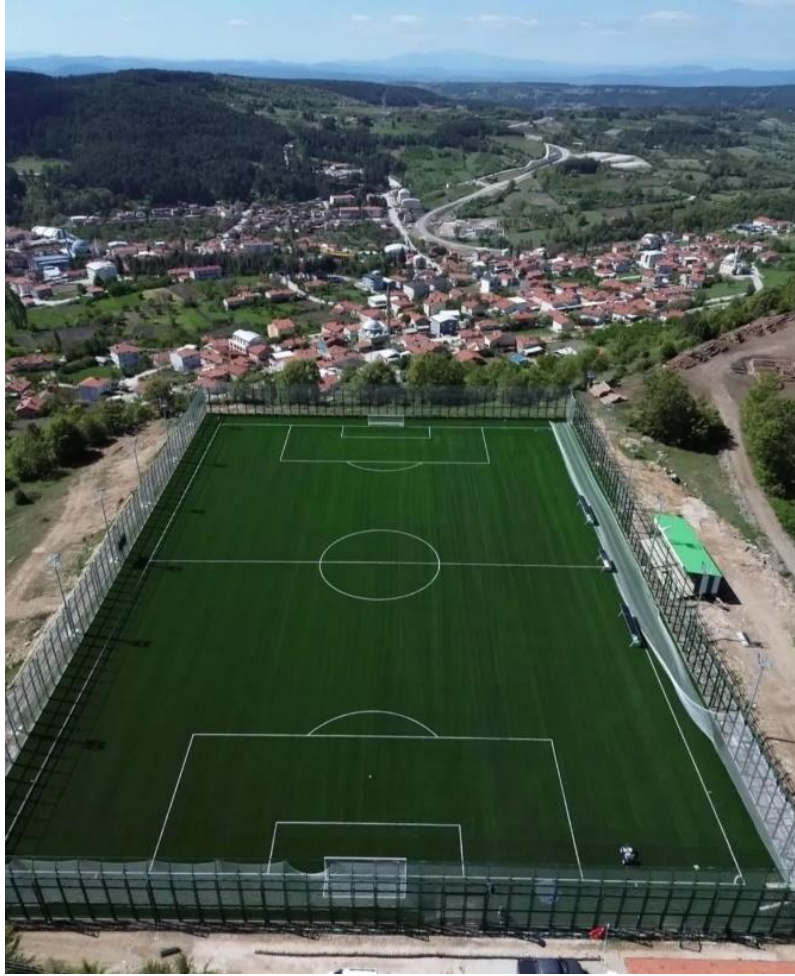
Fotoğraf 3.16. Bursa Keles İlçe Stadyumu (Keles Belediyesi).
