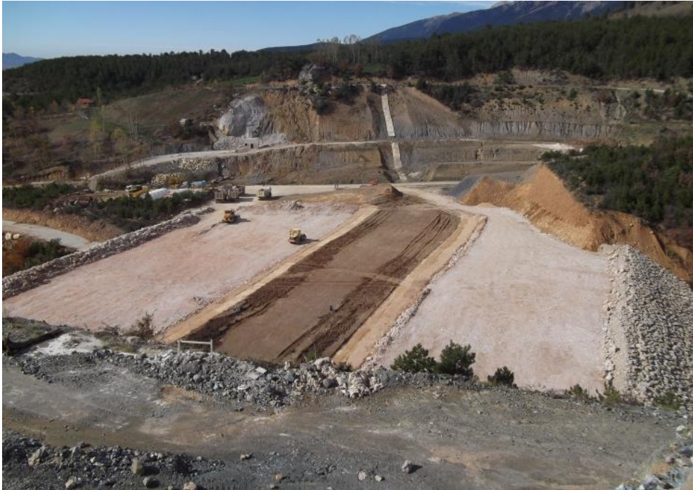
Fotoğraf 3.26. Dağdibi göleti yapım aşaması (ÖZŞA YAPI 2011).
