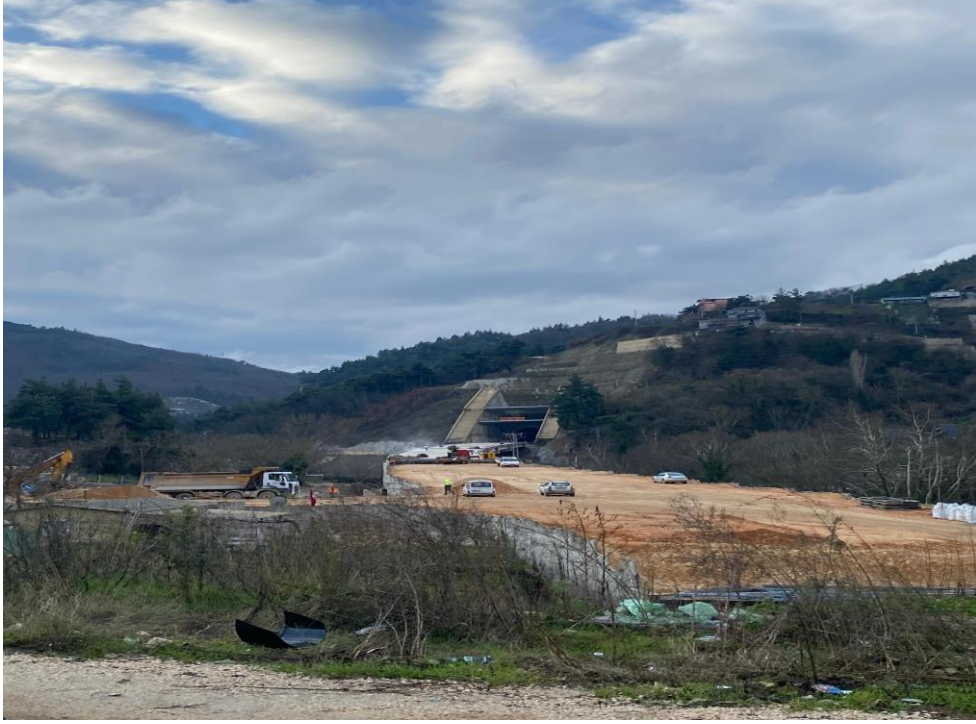
Fotoğraf 3.23. Doğancı Tüneli yapım çalışması (2024)
