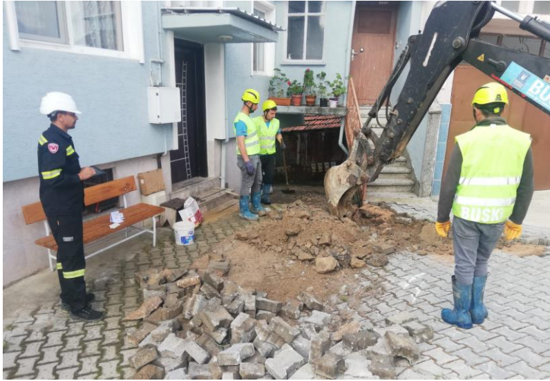
Fotoğraf 3.17. Alt yapı çalışması için kazılan alan (2025).
