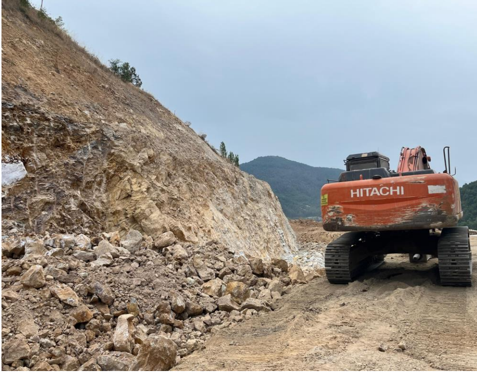
Fotoğraf 3.22. Bursa Keles yol genişletme çalışmaları (2024).
