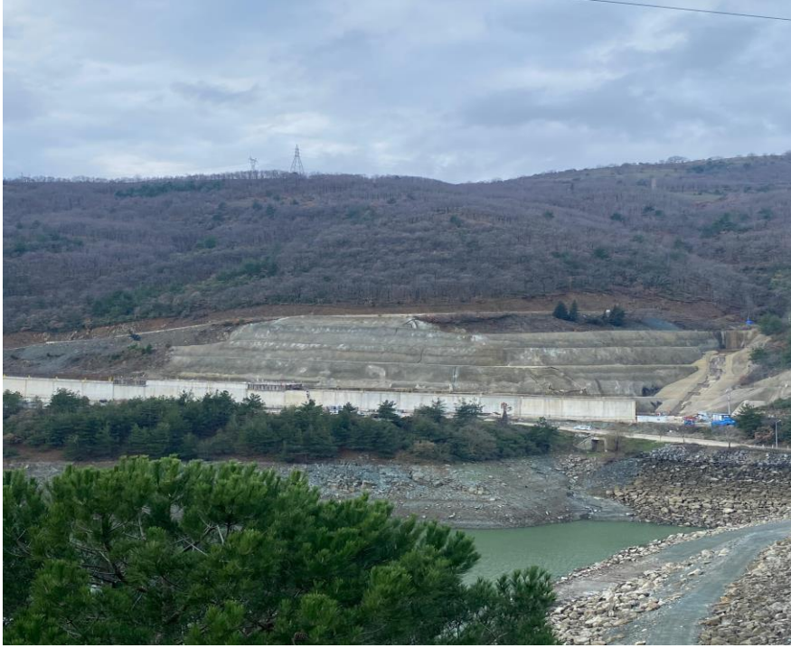
Fotoğraf 3. 14. Doğancı Barajı Üst yolunda teraslama (2024).
