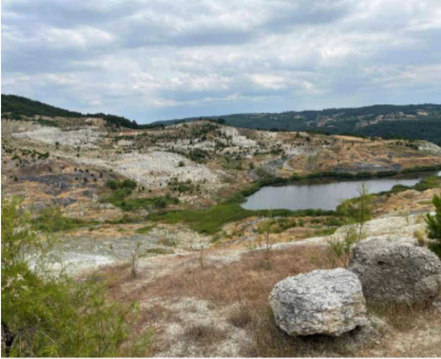
Fotoğraf 3.7. Oyulmaların olduğu alanlarda boyutu fazla olmayan su birikintileri harmanalanı maden içi ufak baraj görüntüsü (2025).
