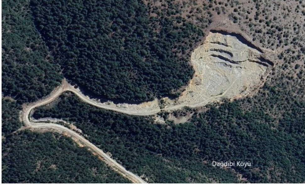
Şekil 3.4. Dağdibi Köyü baraj yapımı için kazılan alan, 2023
