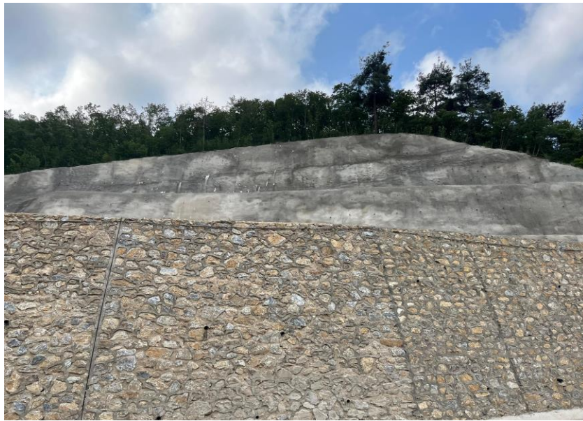
Fotoğraf 3.39. Bursa Keles yolu teraslama çalışması.
