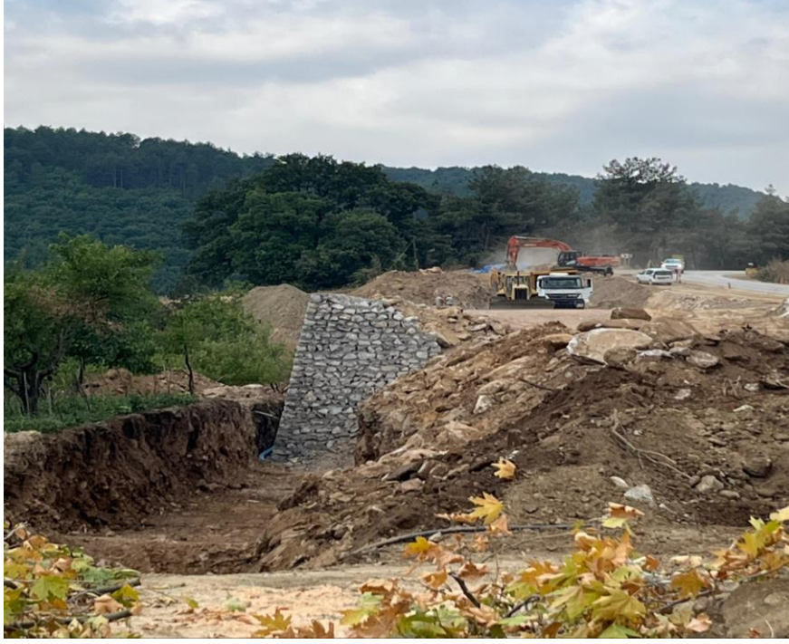
Fotoğraf 3.20. Bursa Keles, yol genişletme çalışmaları (2024).
