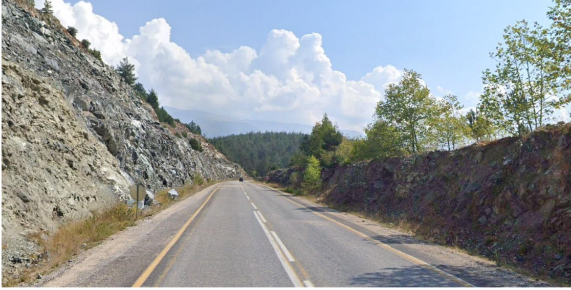
Fotoğraf 3.25. Yol yapım çalışması için dağ yamacının yarılması (2023).
