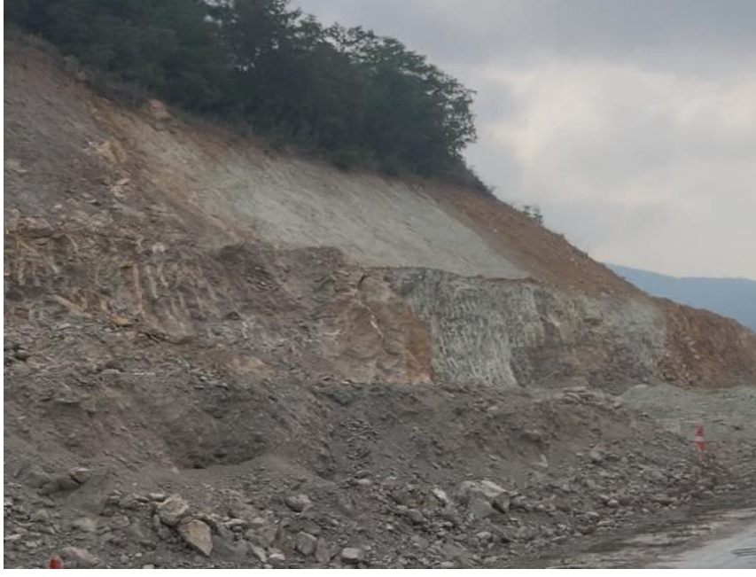
Fotoğraf 3.13. Yol kenarına yapılan teraslama çalışması (2024).
