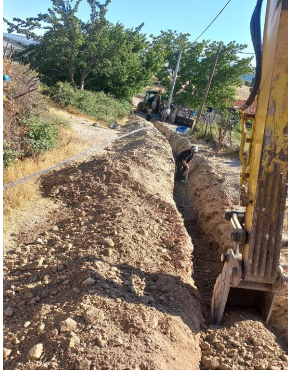
Fotoğraf 3.18. Keles ilçesinde alt yapı çalışması için kazılan alan (2025).
