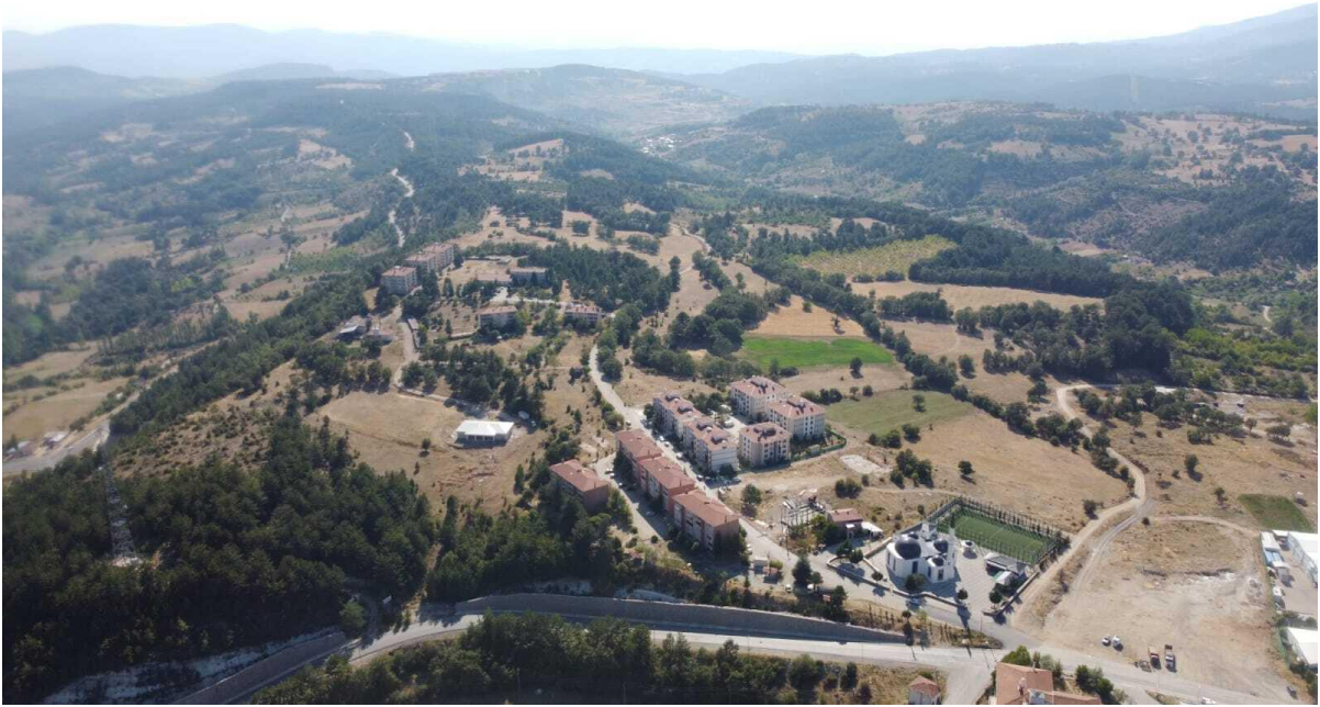
Fotoğraf 3.10. Keles TOKİ alanlarında park, bahçe ve yol yapımı sırasında yapılan dolgu çalışmaları (Keles Belediyesi).
