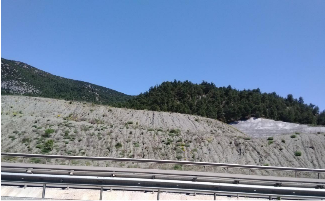
Şekil 4.23. Yüzeysel Akışın İleri Safhası Olan Parmak Erozyonundan Görüntü (Karasu Vadisi Doğu Yamacı).
