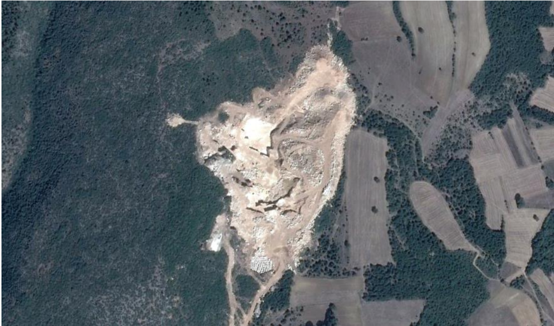
Şekil 4.12. Güllümbe Köyü Mermer Ocağı(Çıkarım Alanı 25.345m 2 , Boşaltım Alanı 41.454 m 2 ) Google Earth Uydu Görüntüsü (12.09.2013).
