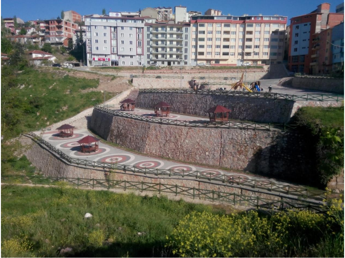
Şekil 4.19. Hamsu Deresinde Tamamlanan Çalışmalardan Bir Görüntü (10.05.2015).
