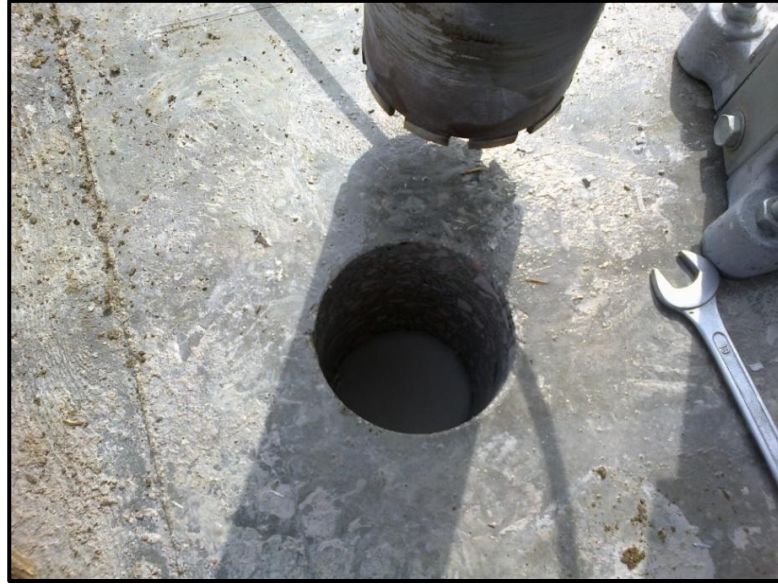
Şekil 4.11 Döşemeden alınan karot boşluğu.
