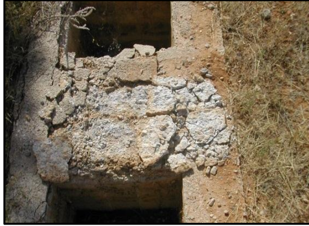
Şekil 2.3 Betonda donma-çözölmeye olayı (Baradan ve Aydın, 2013).
