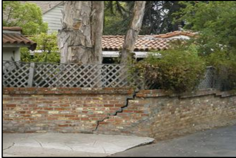
Şekil 2.12 Betonarme yapıda oluşan biyolojik kalıcılık sorunu.
