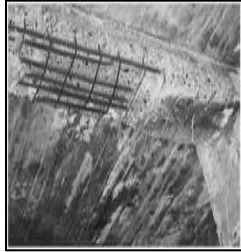
Şekil 2.5 Sıcaklığın betona etkisi.
