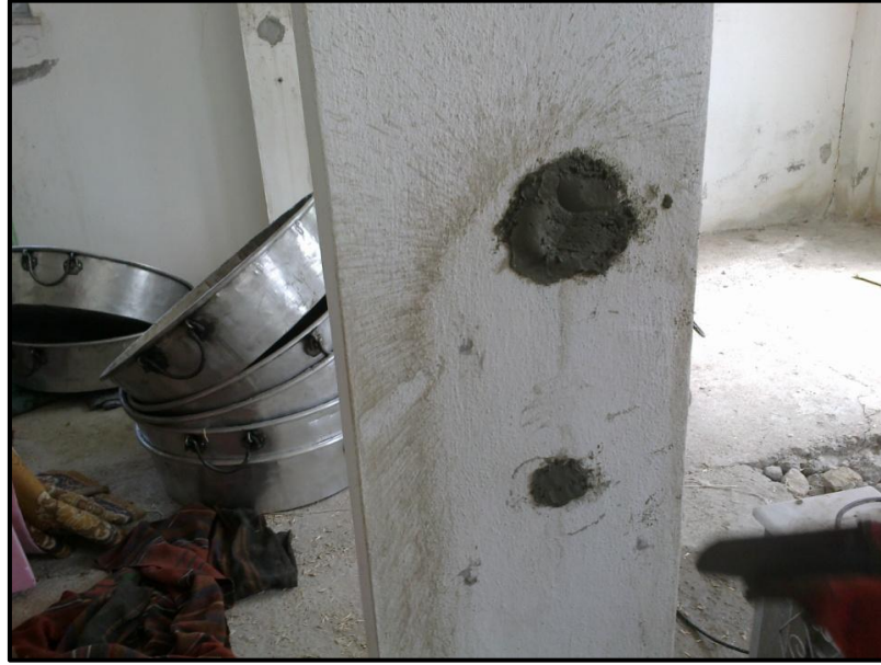
Şekil 4.13 Onarılmış karot boşluğu.
