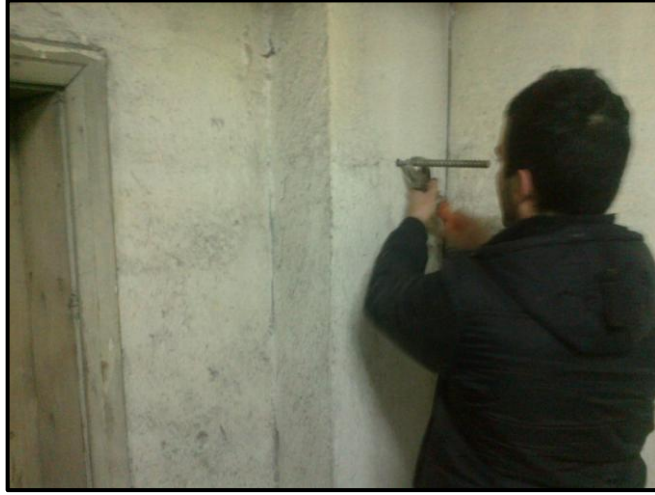
Şekil 4.3 Cihaz sabitleme dübelinin montajı.
