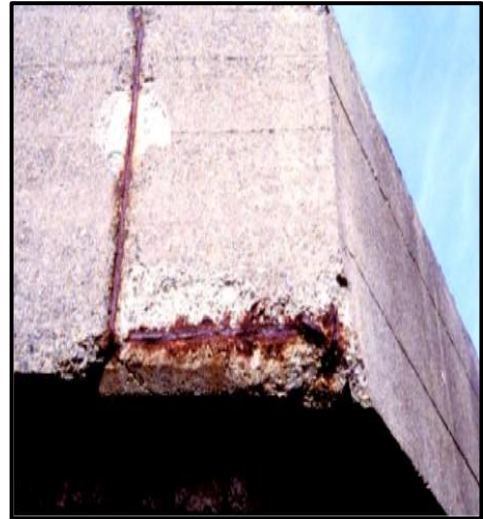
Şekil 2.10 Donatının korozyonu.
