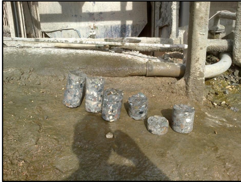
Şekil 4.10 Yapı elemanlarından alınmış karot numuneleri.
