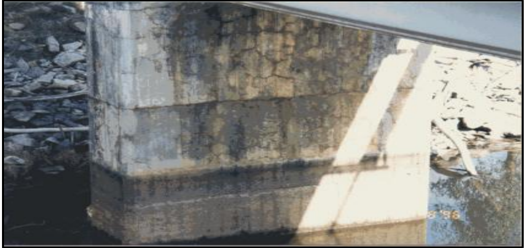
Şekil 2.6 Kimyasal reaksiyona maruz kalan betonun bozulması.
