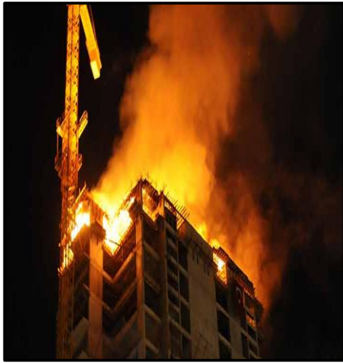
Şekil 2.4 Yüksek sıcaklık altında beton.
