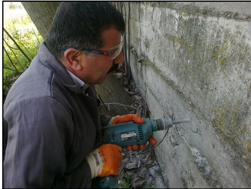
Şekil 4.2 Karot alınacak elemana sabitleme dübel deliği açılması.
