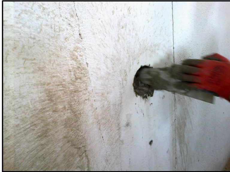
Şekil 4.12 Karot boşluğunun onarım harcıyla tamiri.
