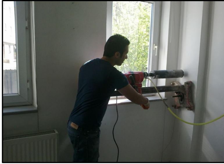
Şekil 4.8 Karot kesimine başlanması.
