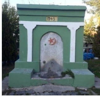
Foto 4.27. Hoca Müftü Çeşmesi
