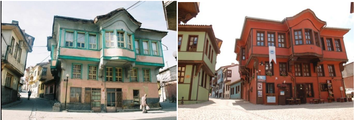
Foto 3.4. Işıklar Sokak, Sağlıklaştırma Öncesi ve Sonrası Durumu
