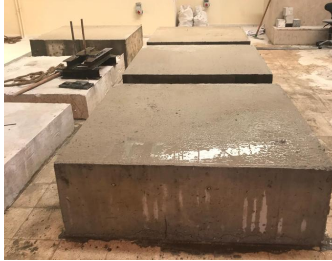
Şekil 4.3. Ankrajların Ekildiği Beton Bloklar
