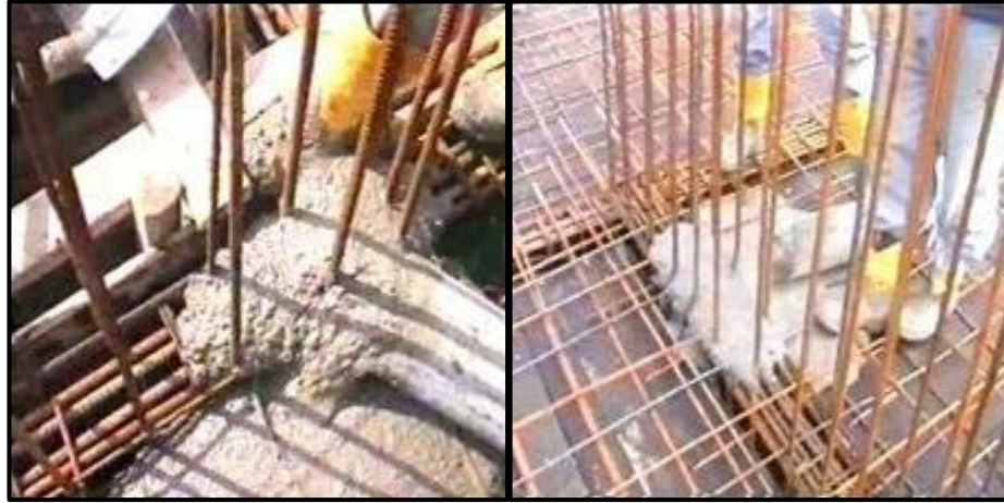
Şekil 2.5. Donatılar arasından vibrasyona gerek kalmadan KYB geçişi.
