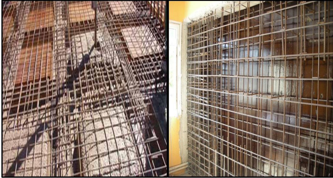
Şekil 2.3. KYB ile betonarme manto uygulamaları.
