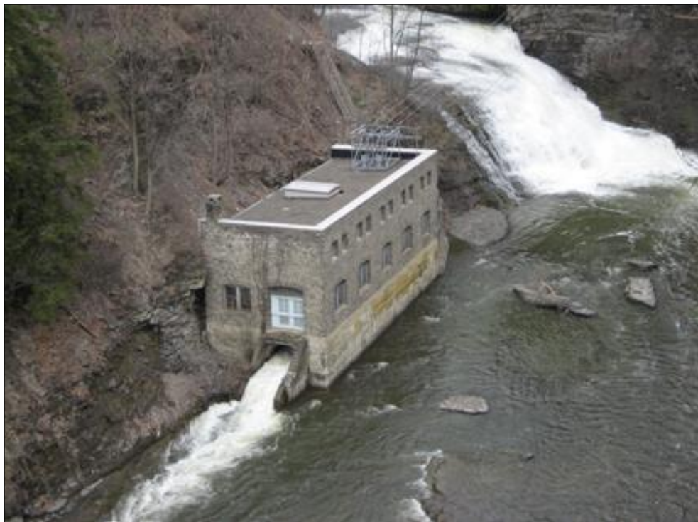
Şekil 2.12. Tipik bir yerüstü santral uygulaması (Cornell University, 2018).
