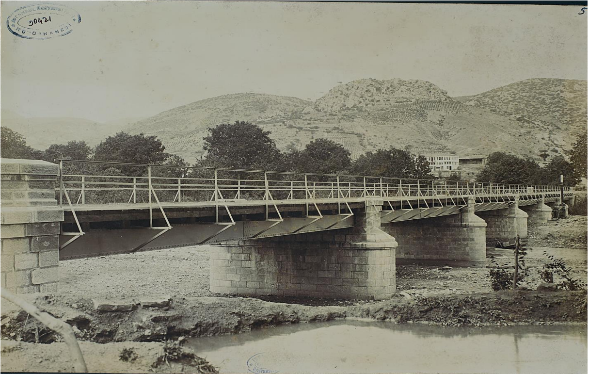
Ek:34 Bilecik Demiryolu İstasyonu'ndan Sögüt'e Uzanan Yolda Karasu Nehri Üzerine Müteahhit Ali Rıza Efendi'nin İnşa Ettiği 100 Metrelik Demir Köprü
