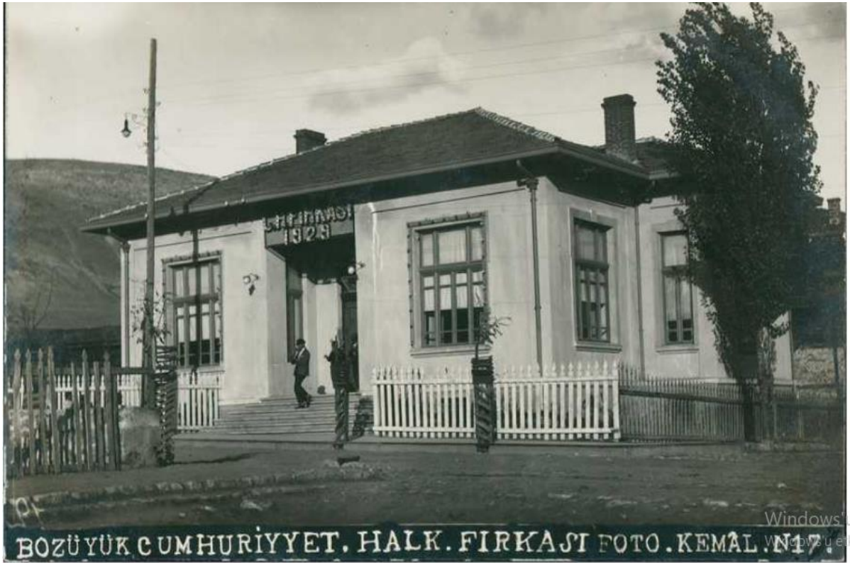
Ek 6: Bozüyük CHF Binası
