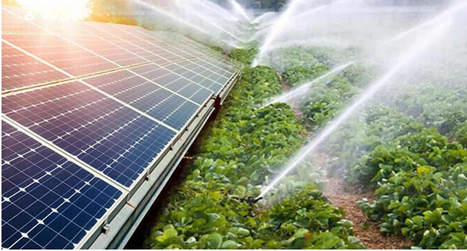
Şekil 2.4. Tarımsal sulama güneş enerji santrali uygulaması
