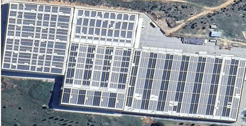
Şekil 2.1. Çatı üstü güneş enerji santrali uygulaması
