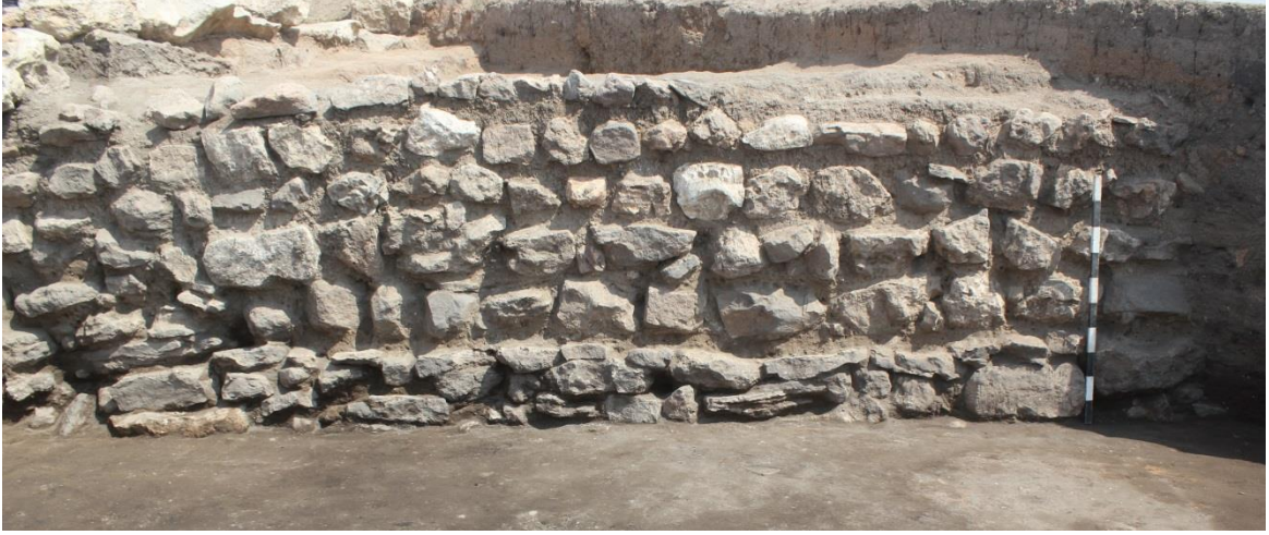
Şekil 6: Yapının kuzey duvarının görünümü
