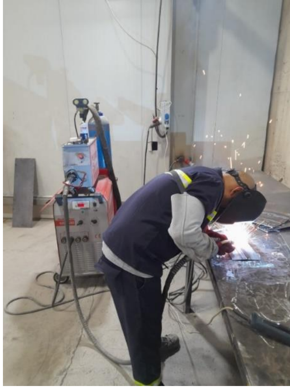
Şekil 4.6. Kaynakçı tarafından yapılan kaynak işlemi
