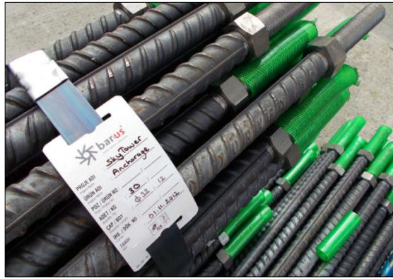
Şekil 2.7. Zemin çivileri (pasif ankraj).
