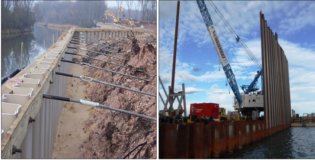
Şekil 2.10. Palplanş imalatı.
