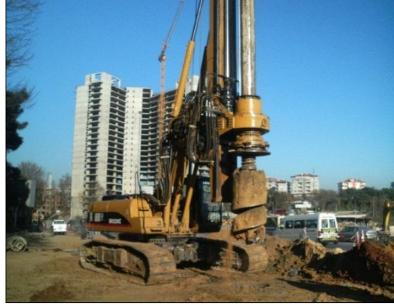
Şekil 2.1. Fore kazık delgi işlemi.
