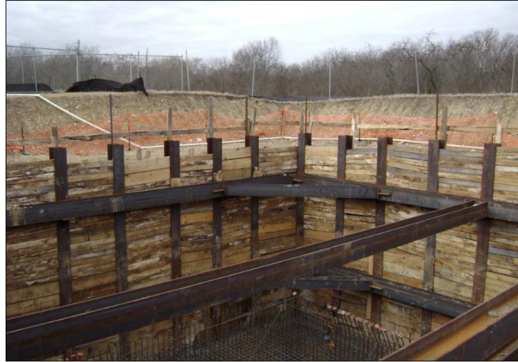
Şekil 2.12 Ahşap palplanş inşaatı.
