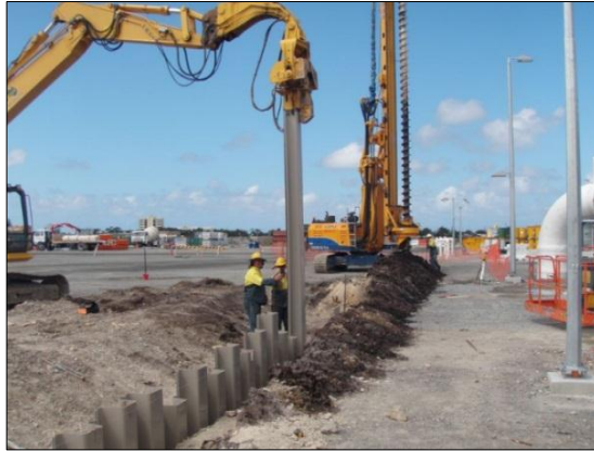
Şekil 2.4. Palplanş perdesi imalatı.
