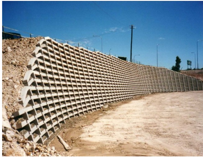
Şekil 5.7. Dolgulu Çerçeve Duvar Uygulaması (Bol E.).
