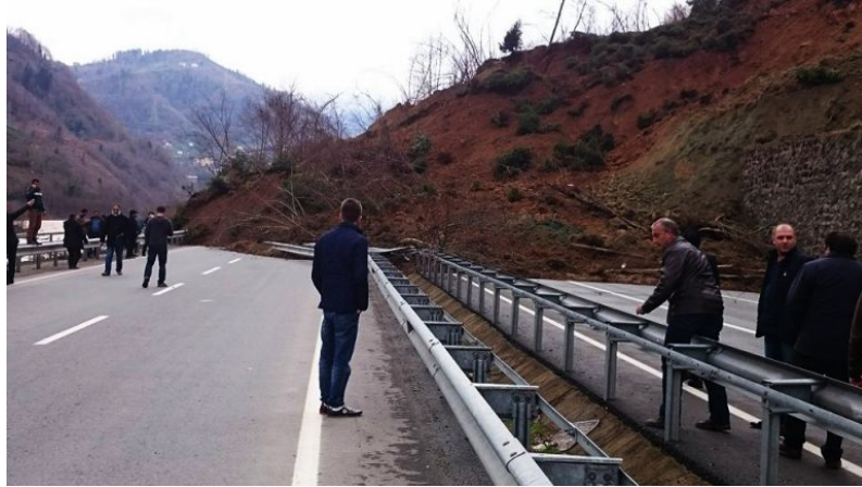
Şekil 3.3. Çaykara-Of yolunda meydana gelen heyelan (Çaykara, 2018).
