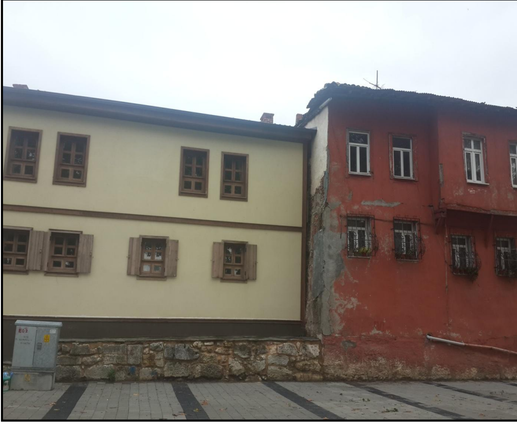
Fotoğraf 2.25: Göllyazı'daki bazı evler Anıtlar Yüksek Kurulu tarafından restore edilmiştir.
