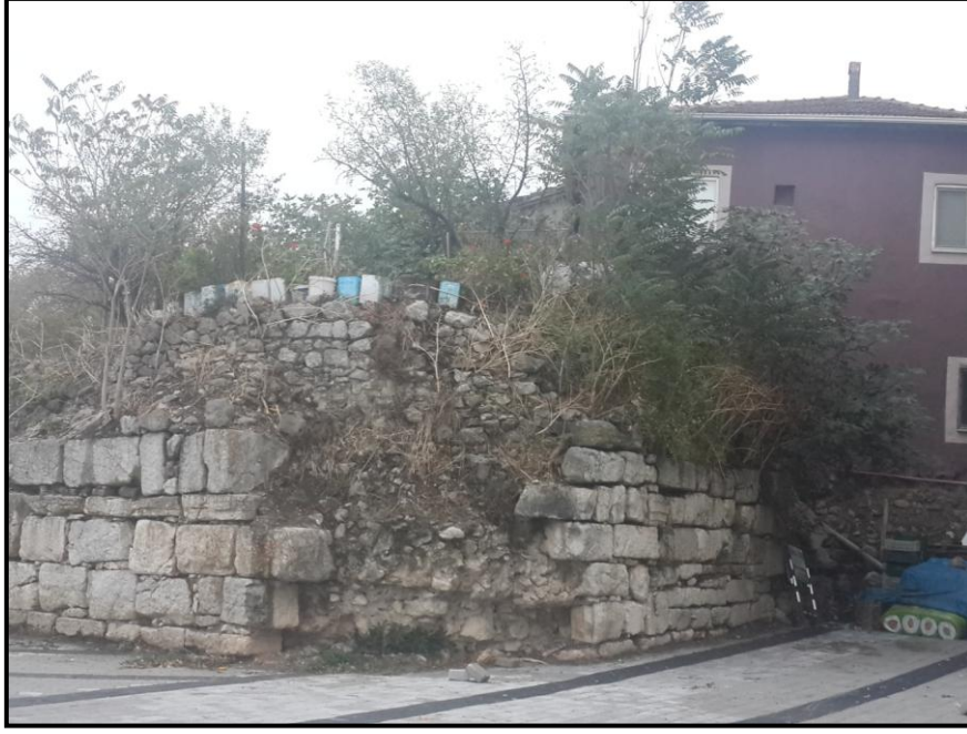
Fotoğraf 2.37: Adanın etrafını çevreleyen duvarlar restore edilmeyi beklemektedir.
