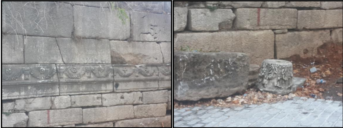
Fotoğraf 2.38-2.39: Kesme taşların üzerinde kabartmalı şekillerden oluşan duvar kalıntıları bulunmaktadır.
