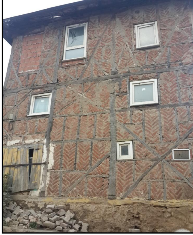
Fotoğraf 3.2: Gölyazı Köyündeki Eski Yapılarda Yaşayan İnsanlar Tadilatlarında Yeni Yapı Malzemeleri Kullanmaktadır.
