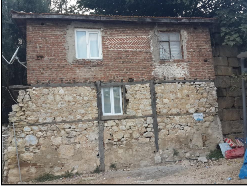
Fotoğraf 3.1: Gölyazı köyünde tarihi yapılar temel olarak değerlendirilerek üzerine yapılan yeni yapılarla birleştirilmiştir.
