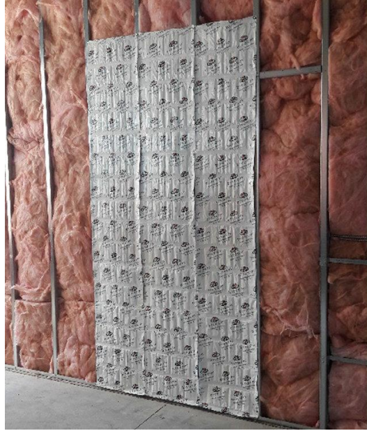
Şekil 2.3. Bir BioFDM'nin duvar zarfına tipik entegrasyonu
