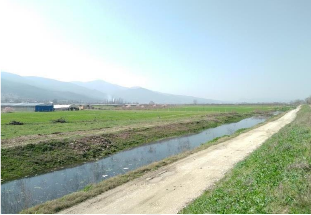
Foto 4.6. Cihadiye Köyü Drenaj Kanalından Bir Görünüm
