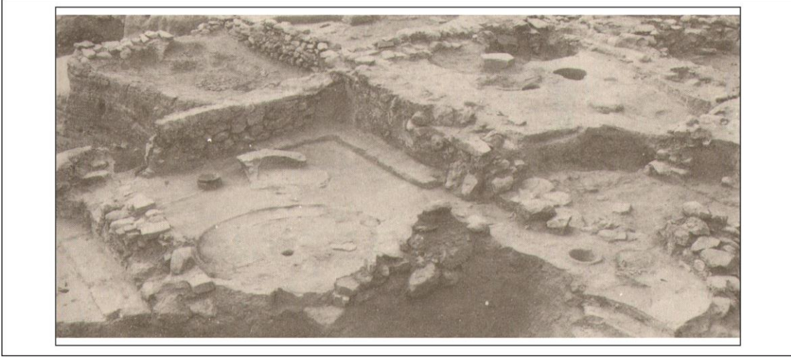
Resim 85: Arslantepe İTÇ IIIA, VI D1 Dönemi Yapı Kalıntılarının Genel Görünümü Kaynak: Frangipane, 1992: Fig. 4b
