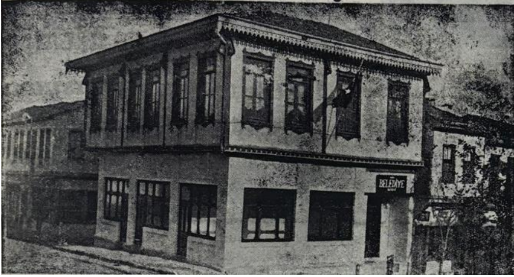
Görsel 4.4. Bilecik Belediye Binası
