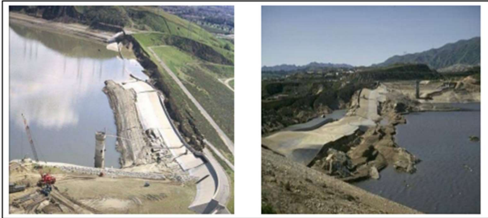
Şekil 4.2. Aşağı San Fernando Barajı'nda 9 Şubat 1971de meydana gelen depremdeki akma türü sıvılaşma
