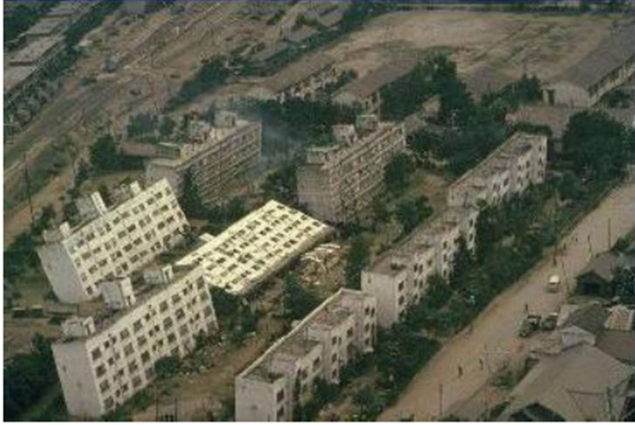
Şekil 4.1. Niigata 1964 Depreminde Sıvılaştan Zemin Görüntüsü
