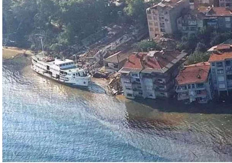
Şekil 4.3. 1999 Kocaeli depreminden yanal yayılma türü sınılaşma hasarı görüntüsü
