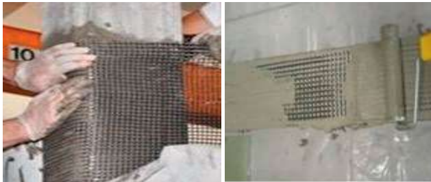
Şekil 1: TRM Uygulaması a) Betonarme Kolon b) Betonarme Kiriş
